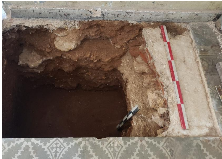
Cimientos del muro de la fachada y el emplazamiento de una de las canaletas de hormigón (derecha de la imagen)
