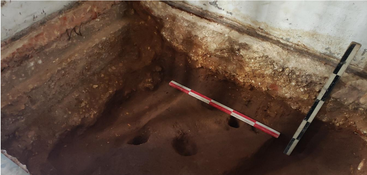
Detalles de los cimientos en los muros de la fachada norte y del medianero este, en la cual se observan las características de su emplazamiento dentro de la vivienda.
