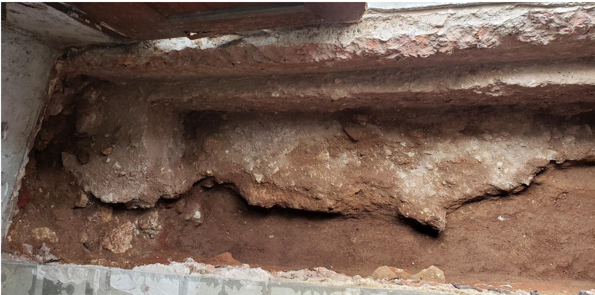
Característica de los cimientos del muro norte y su relación con los cimientos del muro central o de cumbreras hacia la segunda crujía o habitación nordeste. Nótese como la zapata de hormigón se adosan a los cimientos de mampostería en el extremo izquierdo de la imagen.
