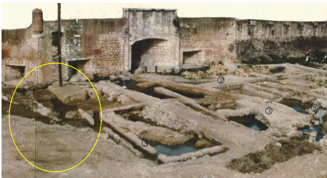
El óvalo color amarillo enmarca la porción del muro de reparación al lado sur del fuerte
