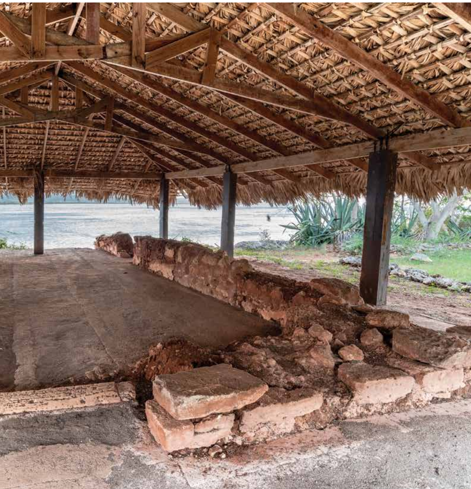
Umbral y arranque de muros en tapia apisonada de la casa-fuerte del almirante Cristóbal Colón. Fotografía de Jorge Selman.
