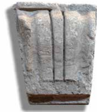
Clave de arco, labrada en piedra, de uno de los edificios de La Isabela. Museo de sitio del parque histórico. Fotografía de Jorge Selman.
