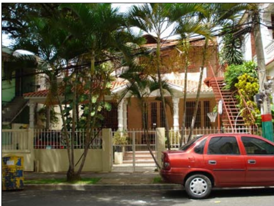
29) LOVATÓN No. 6, SOLAR No. 5-A, MANZANA No. 399
