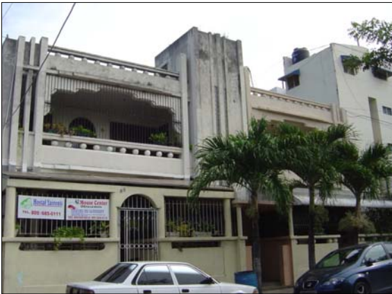
15) SANTIAGO NO. 51 Y 53, SOLAR NO., MANZANA NO. 319
