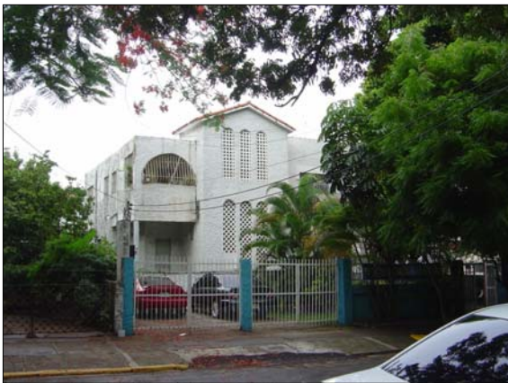
33) CERVANTES ESQ. LEA DE CASTRO NO. 51, SOLAR NO., MANZANA NO. 392
