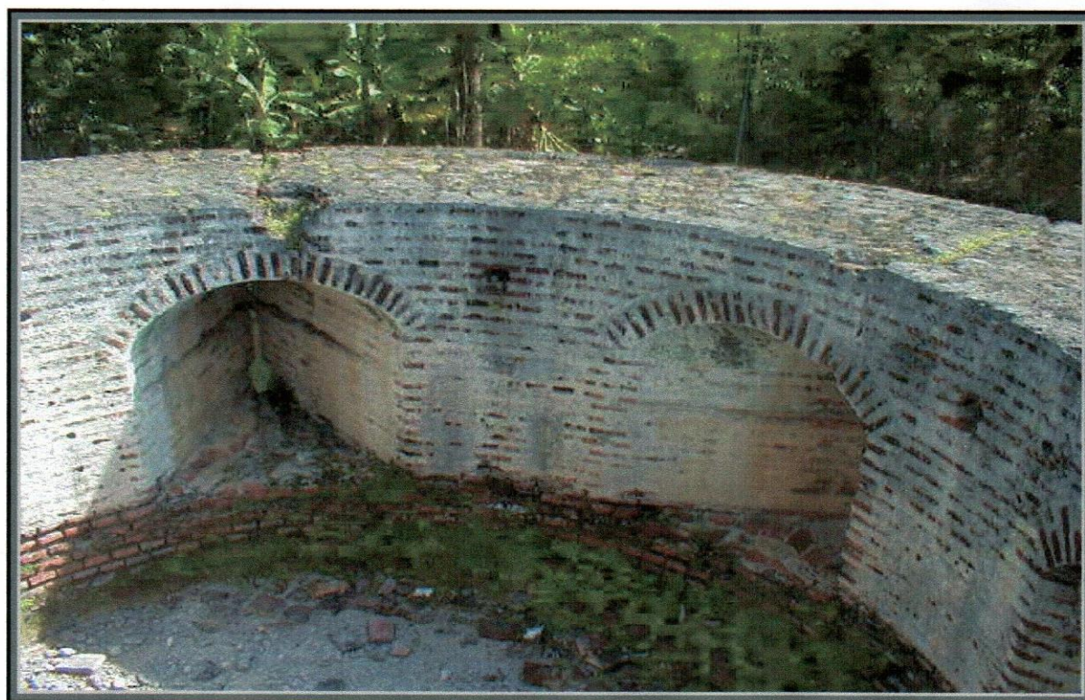
Vega Vieja. Vista interior parcial de la Fortaleza. Grietas en muro. Fotos: CIBC. 07/07/2002.
