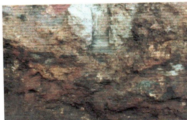
Detalle en la parte superior de la foto, de una huella de listón de madera en el cemento, como evidencia de la última construcción en madera.
