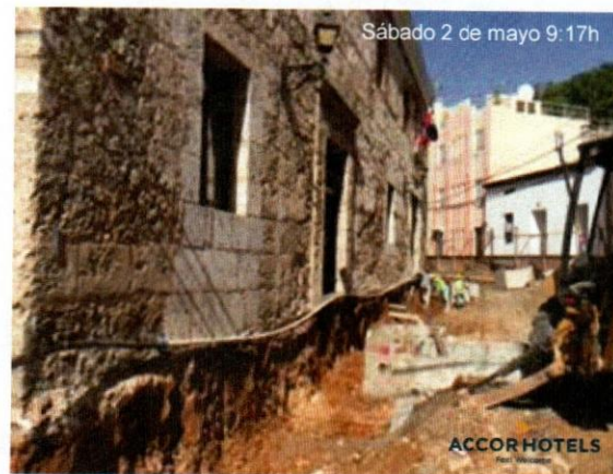
Lámina 14 Amplitud de la zanja de obra a todo el flanco Norte del edificio. Nótense los escasos cimientos de la esquina.'
