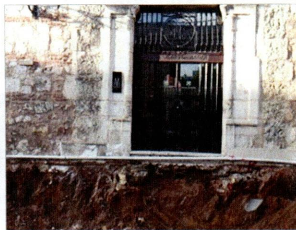
Lámina 24 Fachada de las Mercedes , mostrando la total ausencia de cimientos, salvo muy pocos a pie de jambas del Portal (derecha). ambas fotografías tomadas el Sábado 2 de mayo a las 7:09 h, cortesía de ACCORHOTELS
