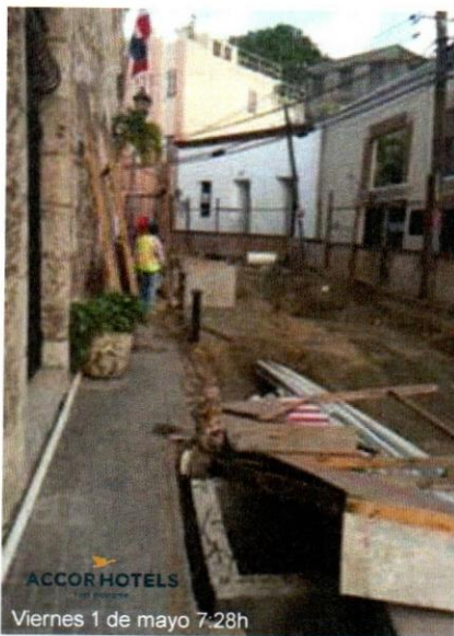
Lámina 13 Acera aún conservada, tubos listos a ser colocados
