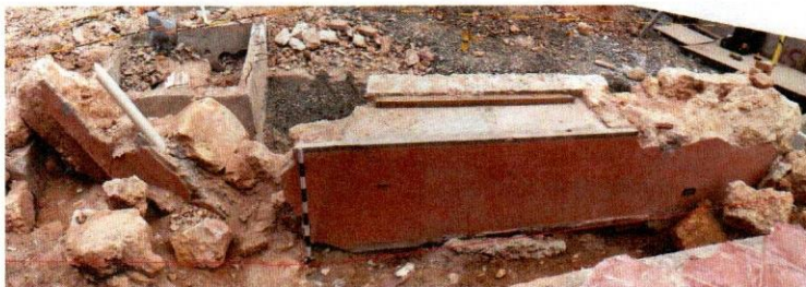
Lámina 22 Primera puerta de la c/ Mercedes tapiada en ventana que resistió al desplomé sector ESQUINA, visto del interior
