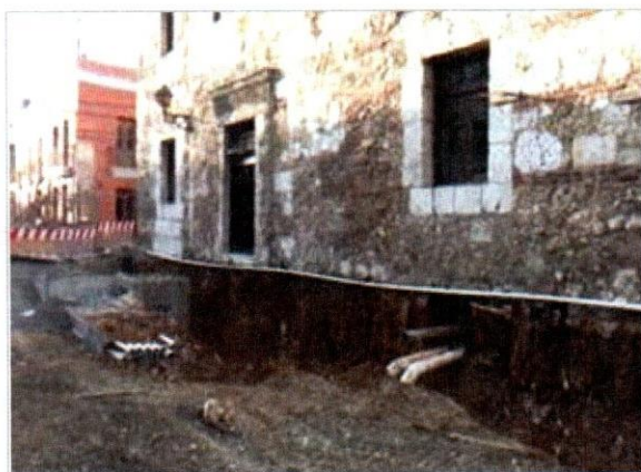
Lámina 24 Fachada de las Mercedes , mostrando la total ausencia de cimientos, salvo muy pocos a pie de jambas del Portal (derecha). ambas fotografías tomadas el Sábado 2 de mayo a las 7:09 h, cortesía de ACCORHOTELS
