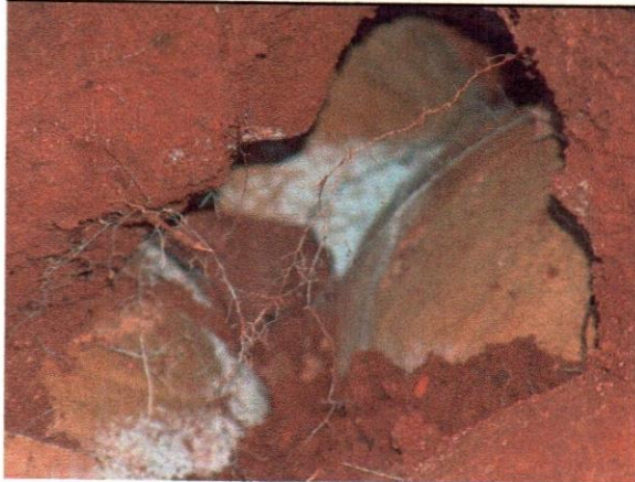
Disposición de las botijas cerámicas colocadas en la cubierta de la capilla de los Dávila, donde se muestra el proceso empleado: Potizas, tejas curvas, tierra, tejas curvas, mortero, y ladrillos.
