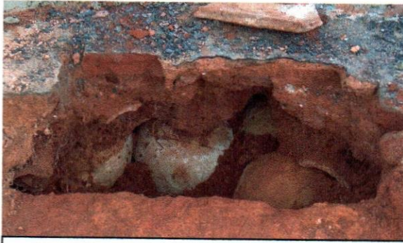
Disposición de las botijas cerámicas colocadas en la cubierta de la capilla de los Dávila, donde se muestra el proceso empleado: Potizas, tejas curvas, tierra, tejas curvas, mortero, y ladrillos.
