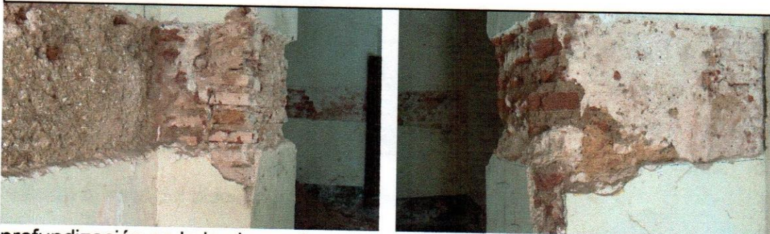
Jambas del arco en el muro central: en la foto de la izq. se observa la porción que se ha agregado a la jamba para reducir la luz del arco.
