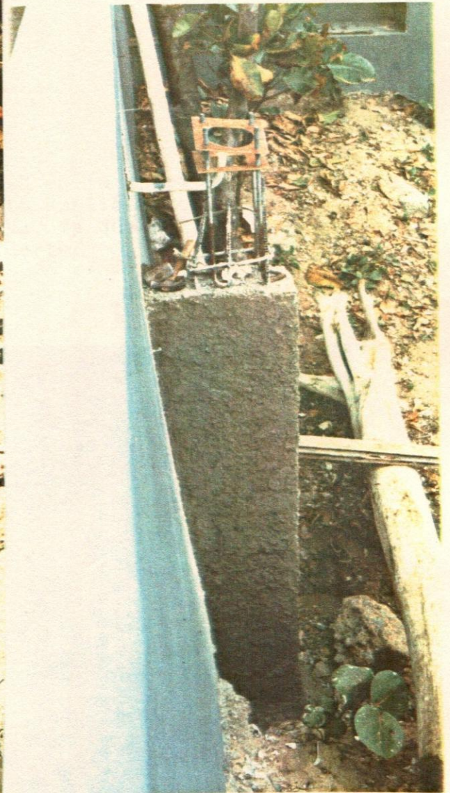
114-A-B y C- Bases de hormigón armado para los postes del alumbrado eléctrico.
