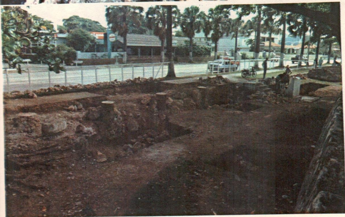
12- Demolición de la acera y del muro de contención
