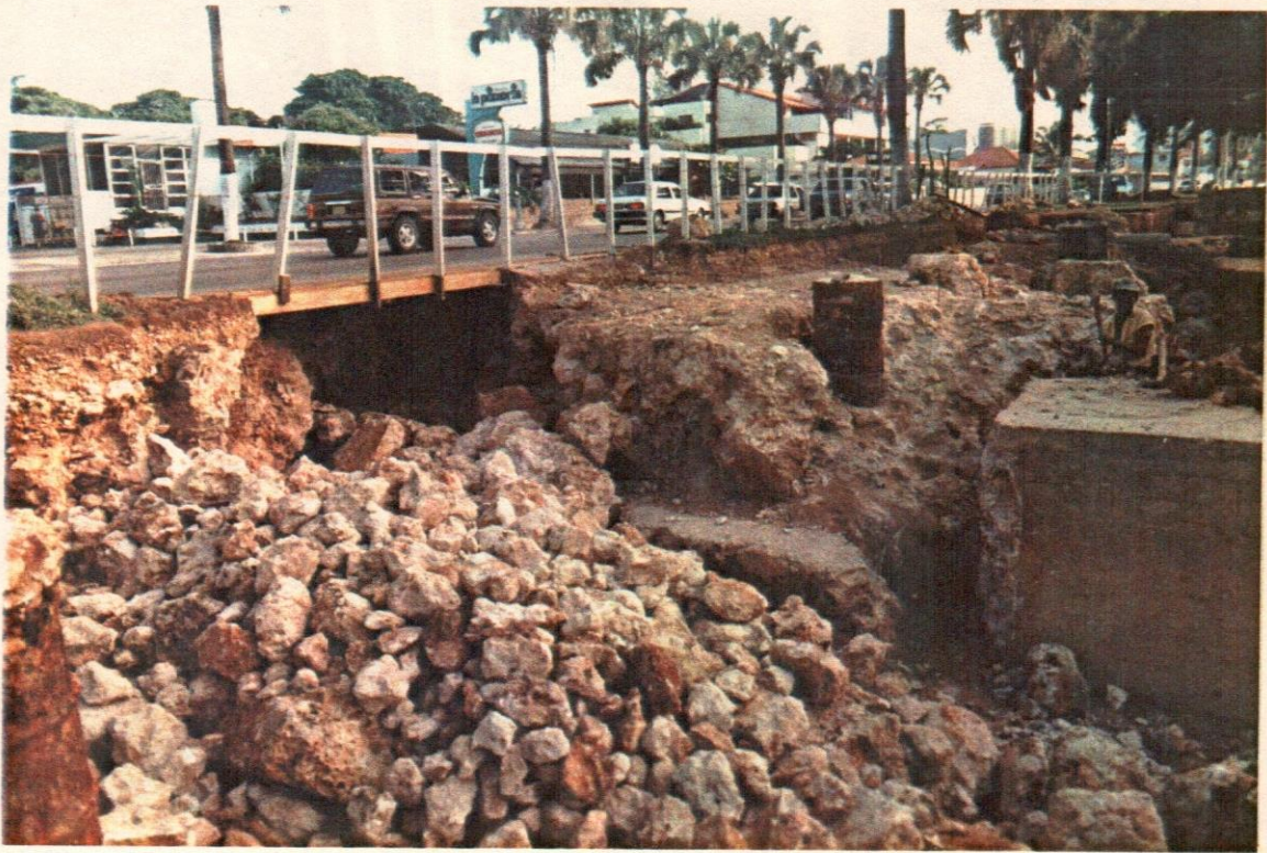
40- Hueco producto de las excavaciones arqueológicas y algunos derrumbe.
