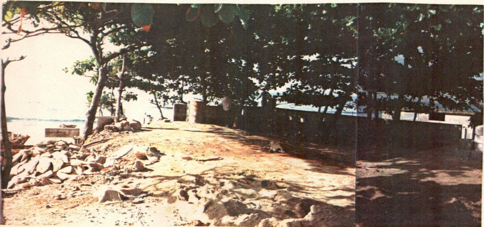
91- Vista de la Plaza Oeste, en construcción.
