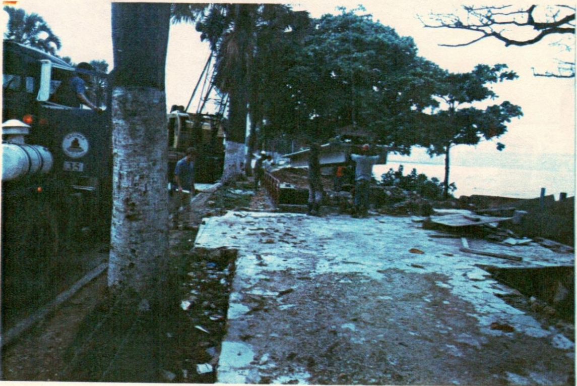
83- Instante en que se instalaba uno de los puentes prefabricados.
