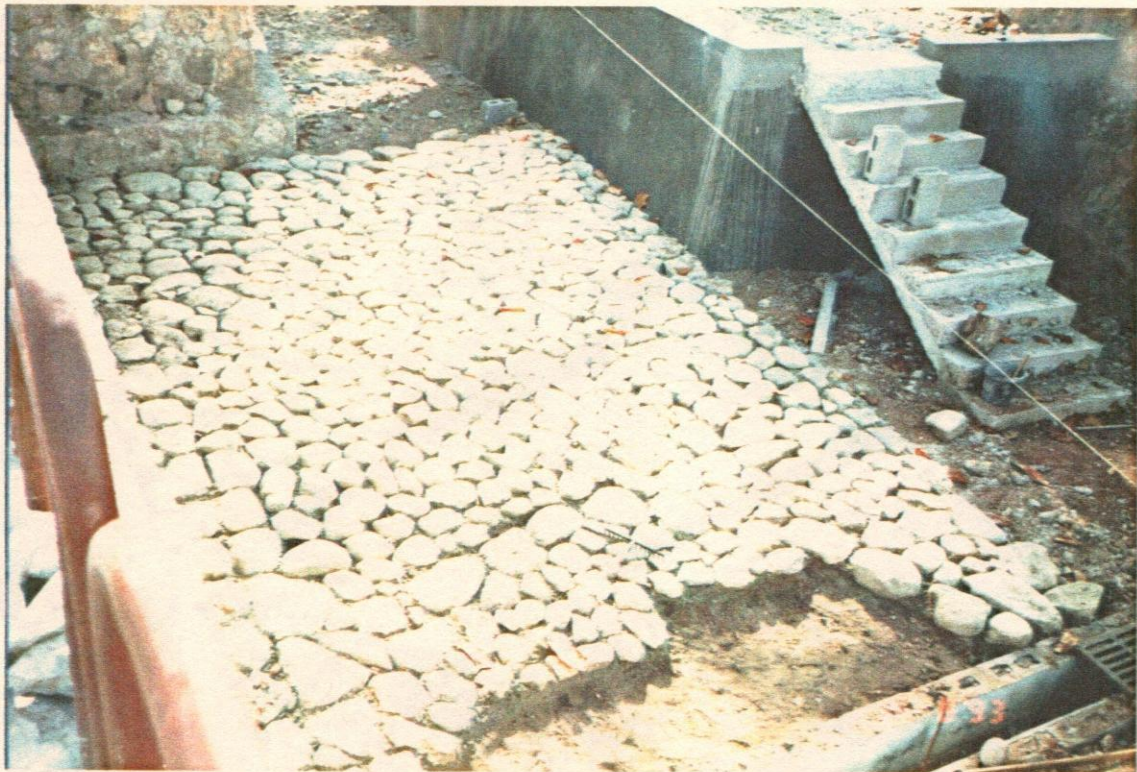
123- Pisos del foso en construcción.
