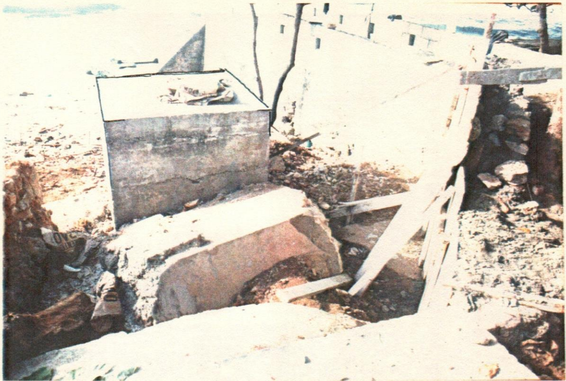
32- Registro en la playa, demolido parcialmente para bajarle la altura.
