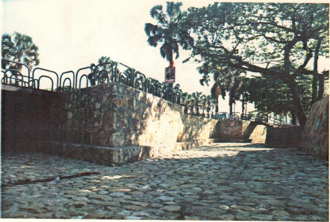
59-A Vista general del Fuerte.
