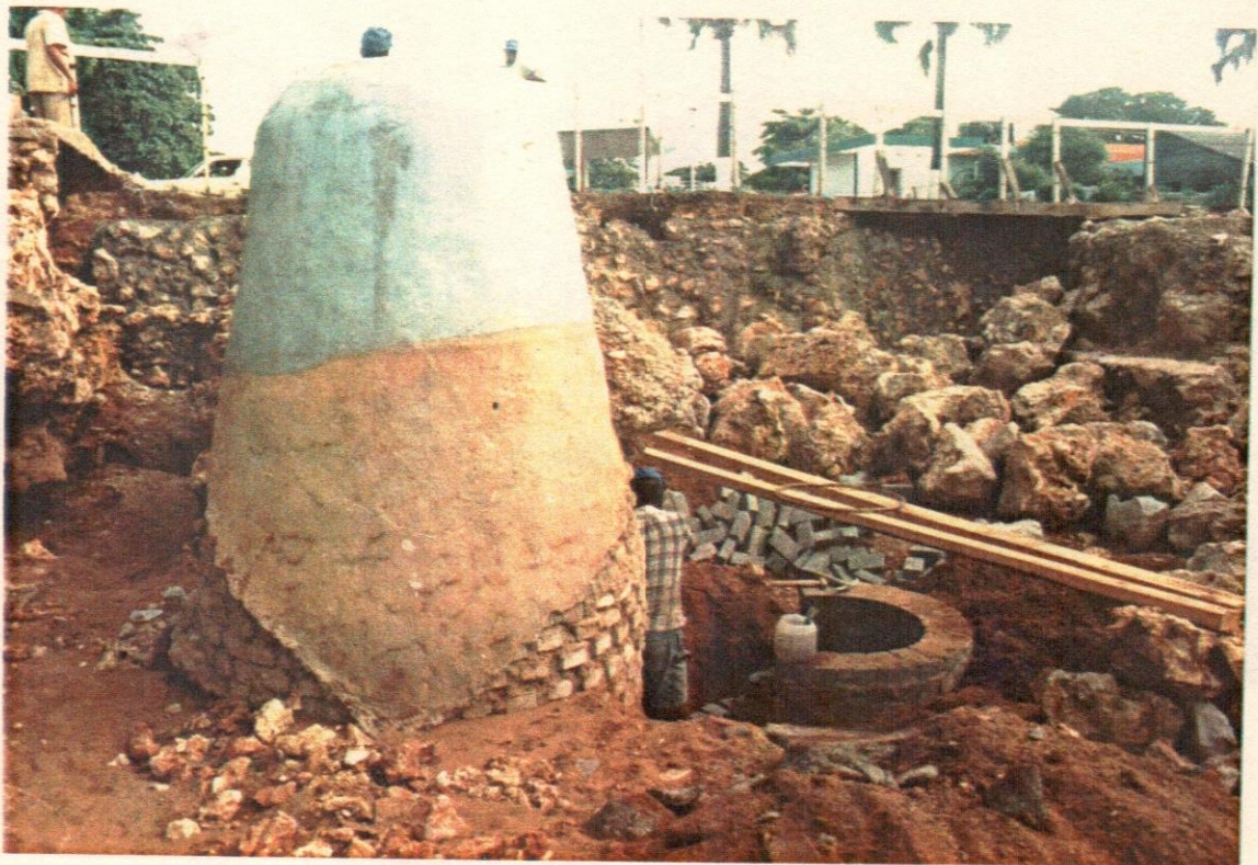
28- Registro sanitario después de la excavación. A la derecha el nuevo registro en construcción, con el nuevo nivel del piso del foso.
