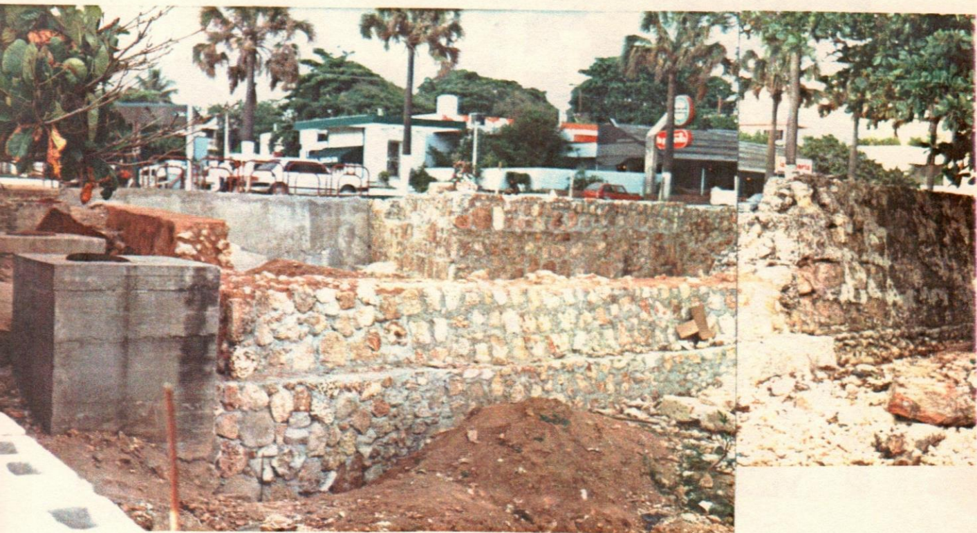
74- Parte Oeste del muro sur reconstruido totalmente desde los cimientos en cara al mar.
