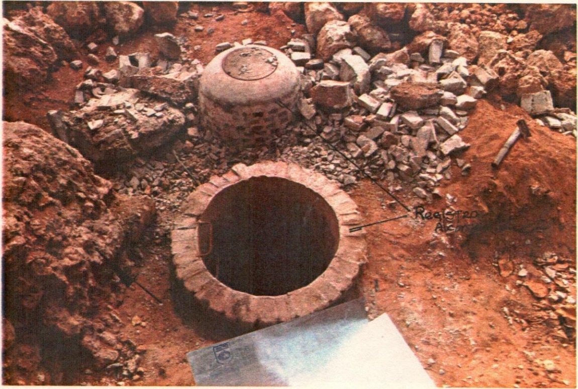
Foto 3-. Detalle de registro de alcantarrillado en área de excavación. Notense parte de sillares de piedras del Fuerte. Calas S1-W13 y 14 N1-W13 y 14.-
