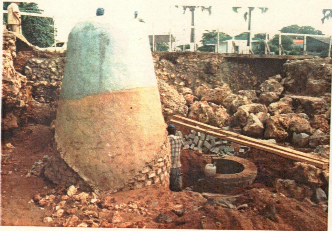
28- Registro sanitario despues de la excavación. A la derecha el nuevo registro en construcción, con el nuevo nivel del piso del foso.
