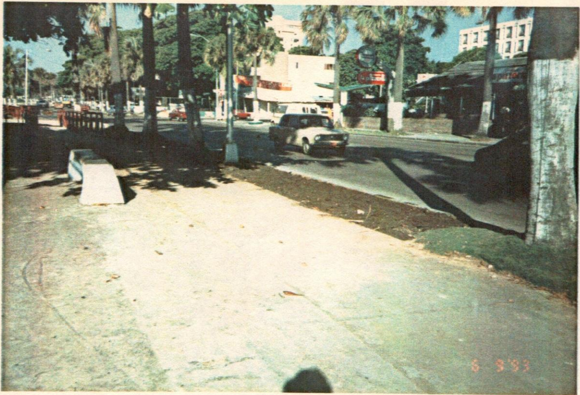
99- En toda el área no pavimentada se preparó con una gruesa capa de tierra negra y se sembró grama por capas.
