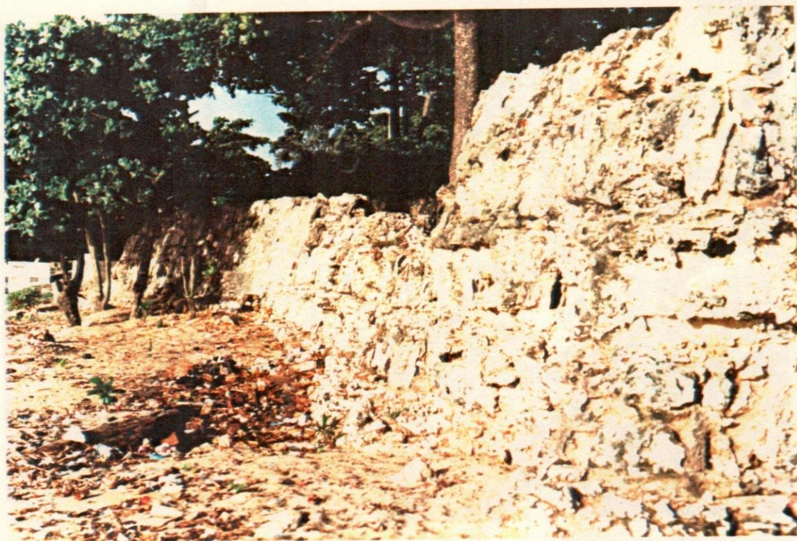
6- Vista del muro sur del foso, desde la Playa.
