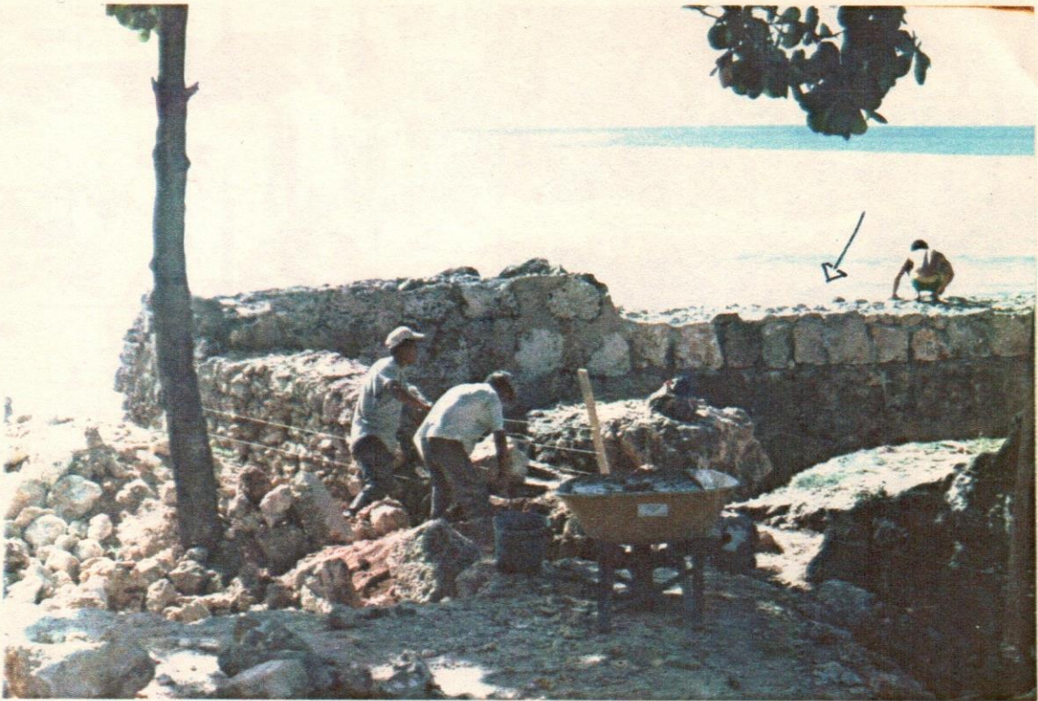
70- Esquina Sur-Este del muro del foso.
