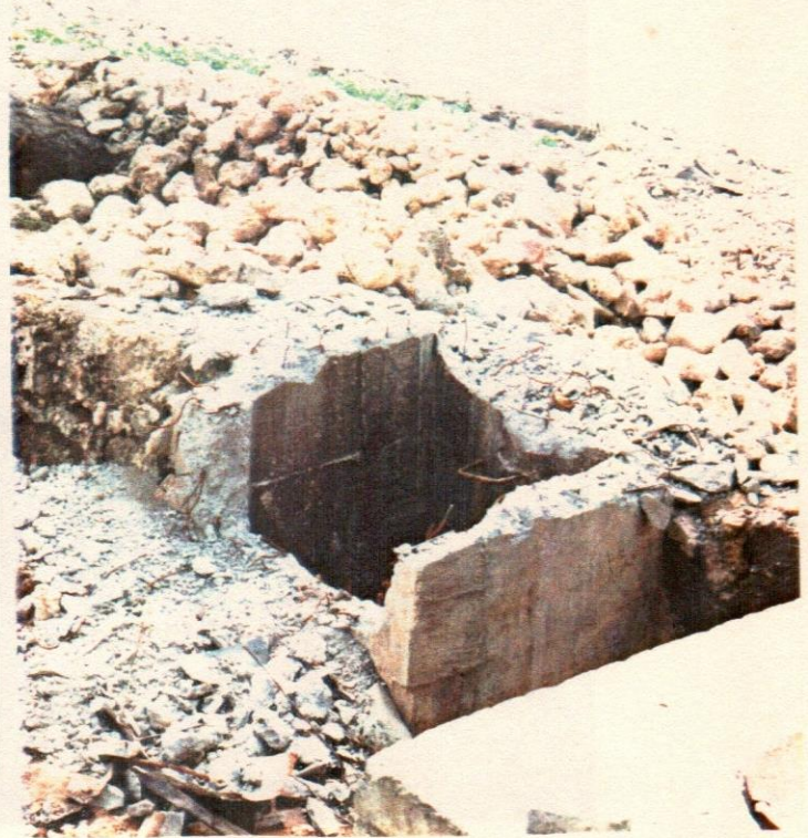
30 y 31- Registro demolido y reconstruido para disimularlo dentro de la muralla. Estado original en la foto No. 27.
