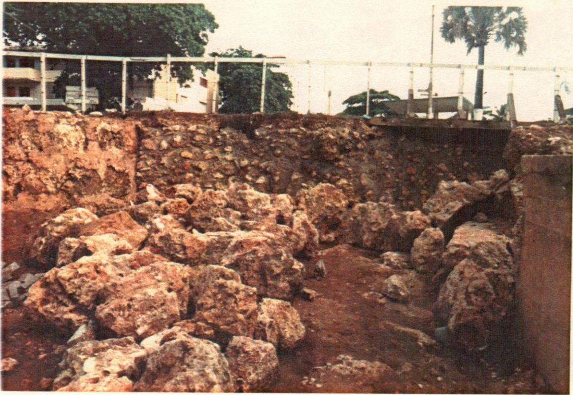
44- Area encachada en el tramo del foso del lado oeste.
