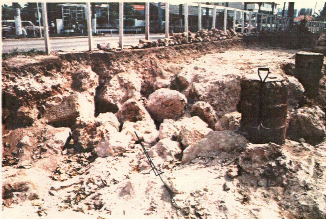
Foto 14-. Detalle de superficie del TERRAPLEN y piedras dispersas, producto posiblemente de la explosión de 1937.
