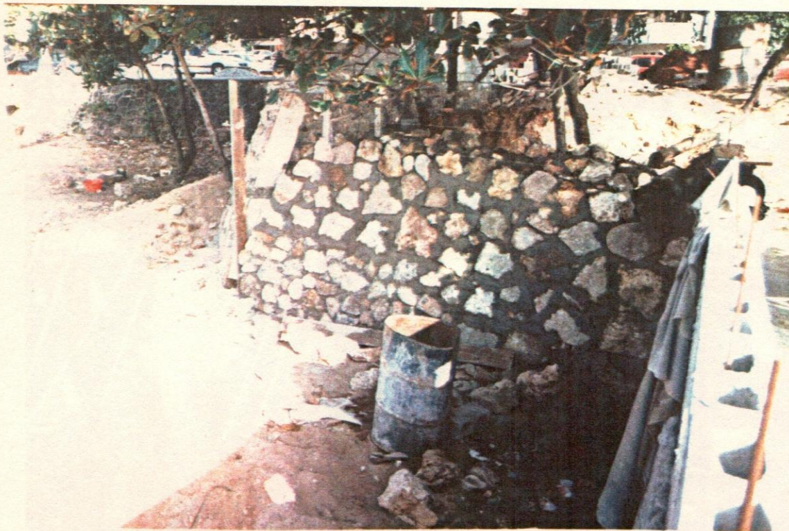
93- Muro de contención al sur de la plaza oeste.
