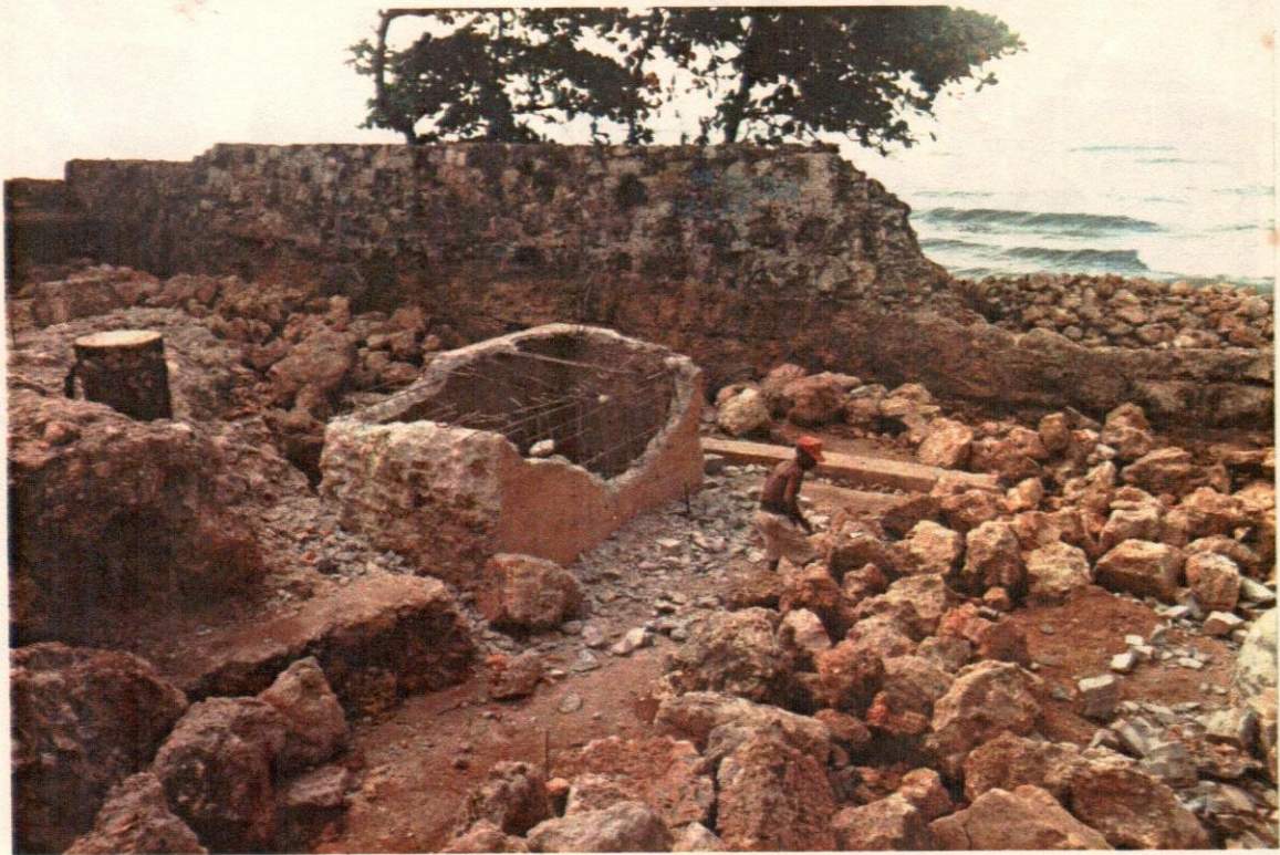
26- Registro gigante, en demolición. En la foto No.15 se puede ver como estaba al inicio de la obra y en las fotos No.18 y 23 se puede observar después de la excavación.
