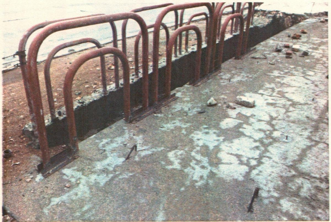
106- Instalación de las barandas en uno de los puentes. Luego fue vaciada una losa de hormigón armado que cubrió los apoyos.
