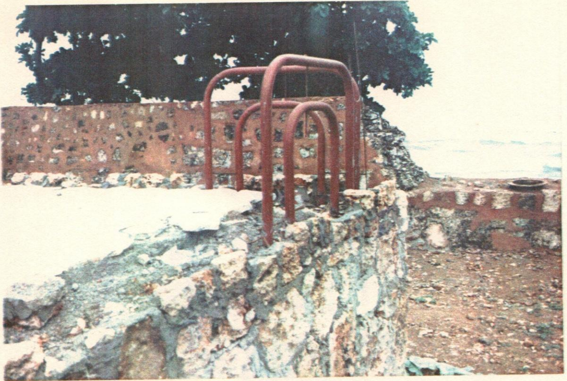
105- Proceso de instalación de las barandas, en tubos Galvanizados de 2'.
