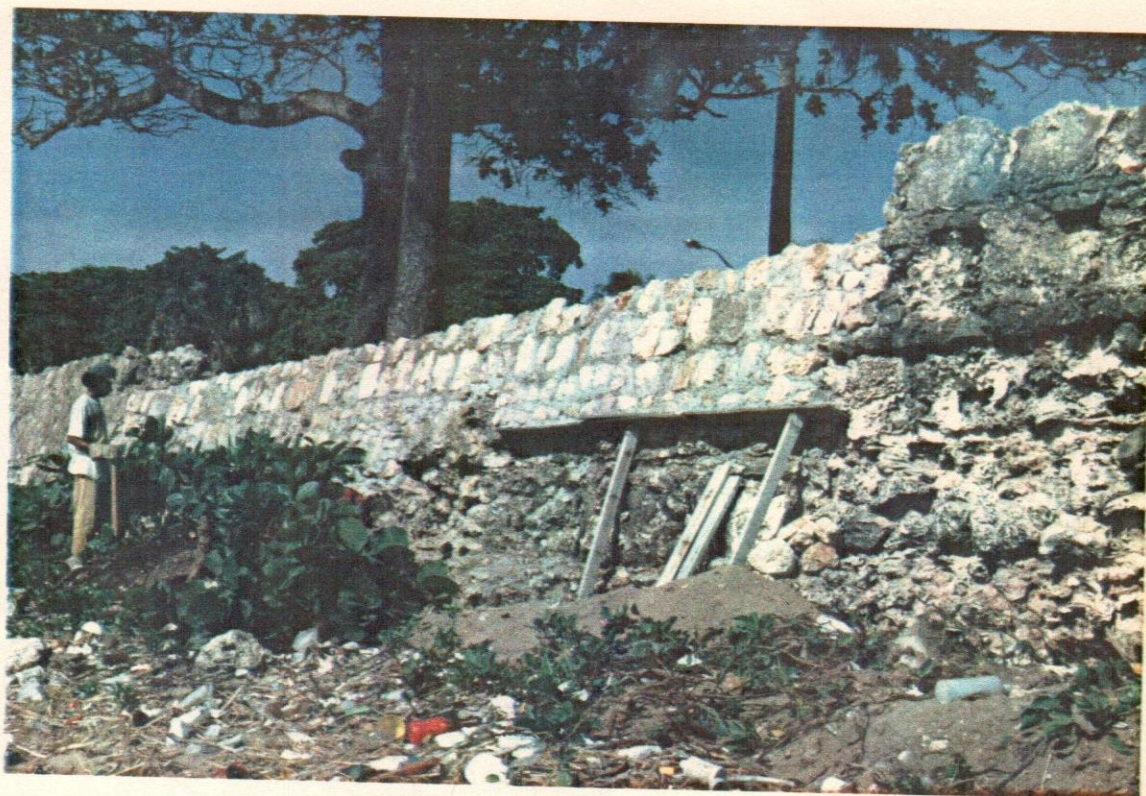
64- Vista general del muro Sur Cara Sur.
