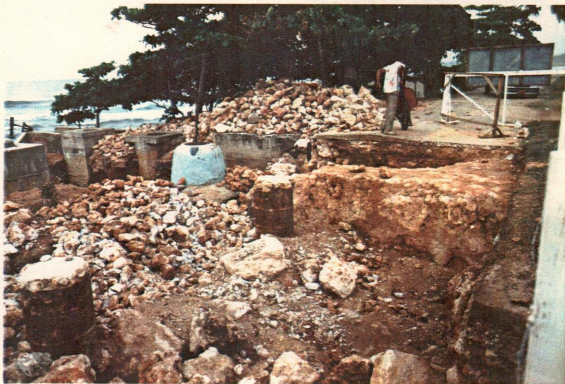
75- Muro oeste del Foso, demolido toda su parte izquierda.
