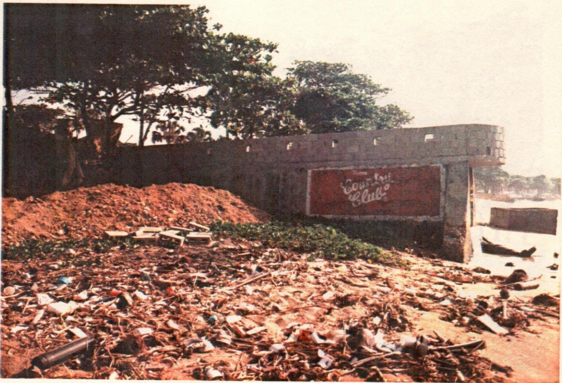
39- Vista del mirador en construcción sobre el canal de desague.
