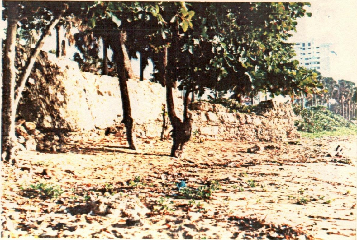
5- Vista del muro sur del foso, hacia la Playa.
