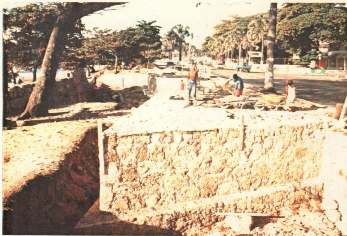
51- Fortín Sur-Este ya reconstruido hasta el nivel que se había decidido. Se observa la colocación del piso.
