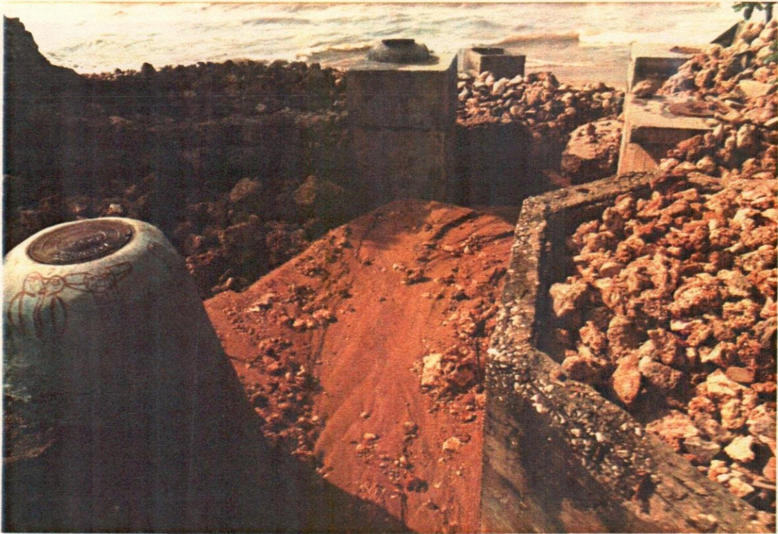
46- Vista de los deslizamientos de tierra producidos por las lluvias.
