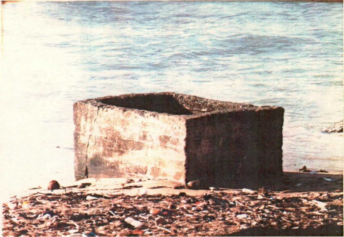
34- Restos de un registro, fuera de funcionamiento, que fue demolido.
