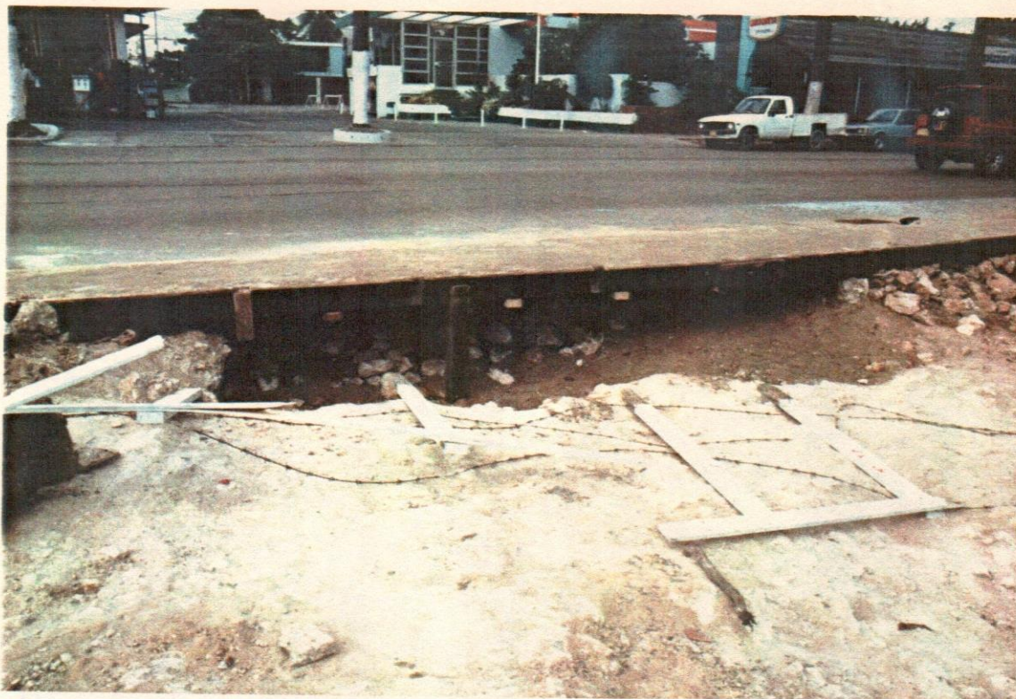
21- Puente en madera para crear un paso peatonal.
