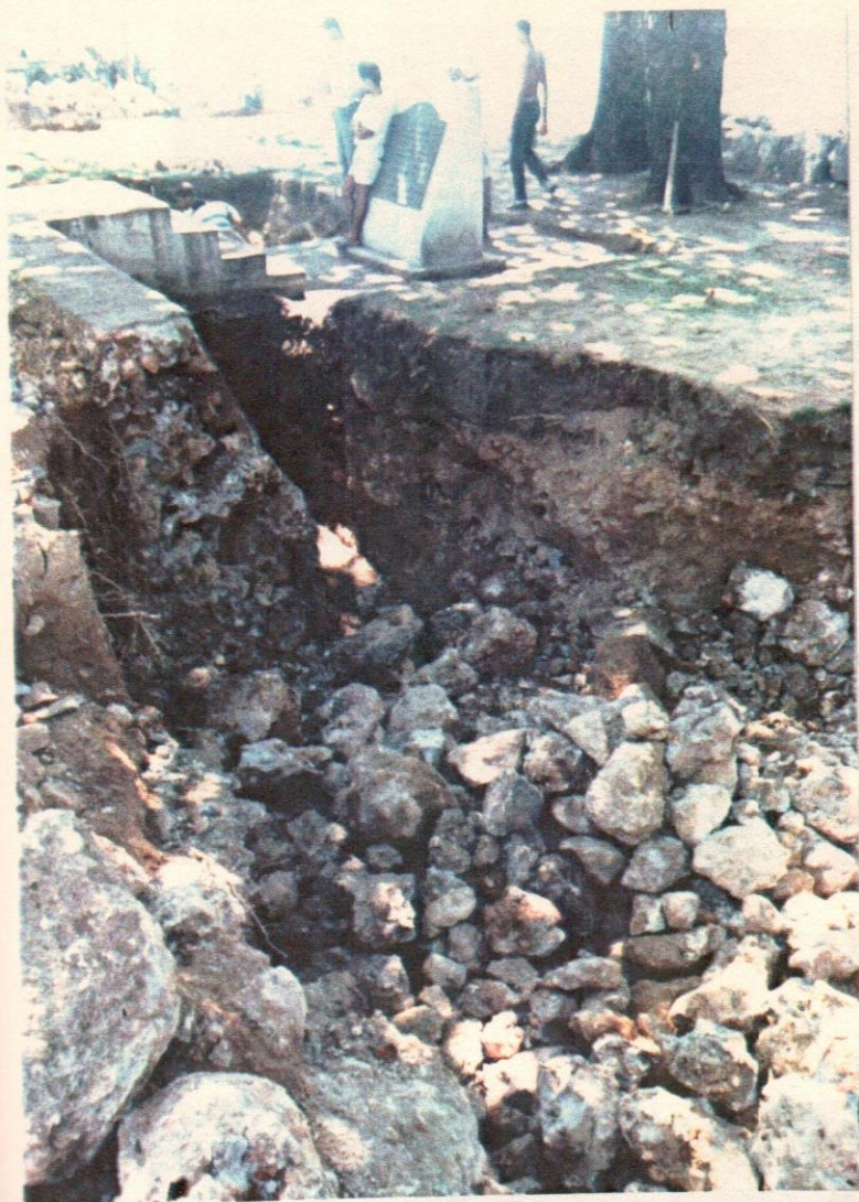
11- Sección del muro de contención de la avenida George Washington, construido antes de que toda esa area hacia la playa se llenara de tierra y escombros.
