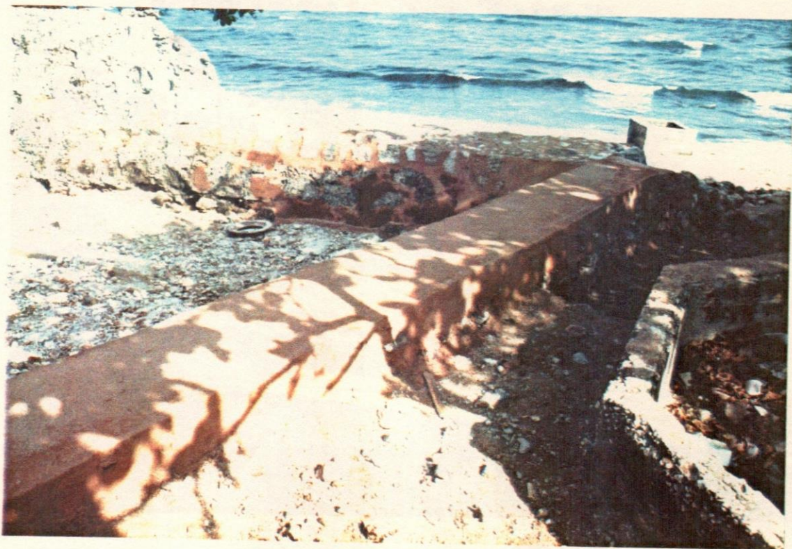
79- Muro oeste ya reconstruido.
