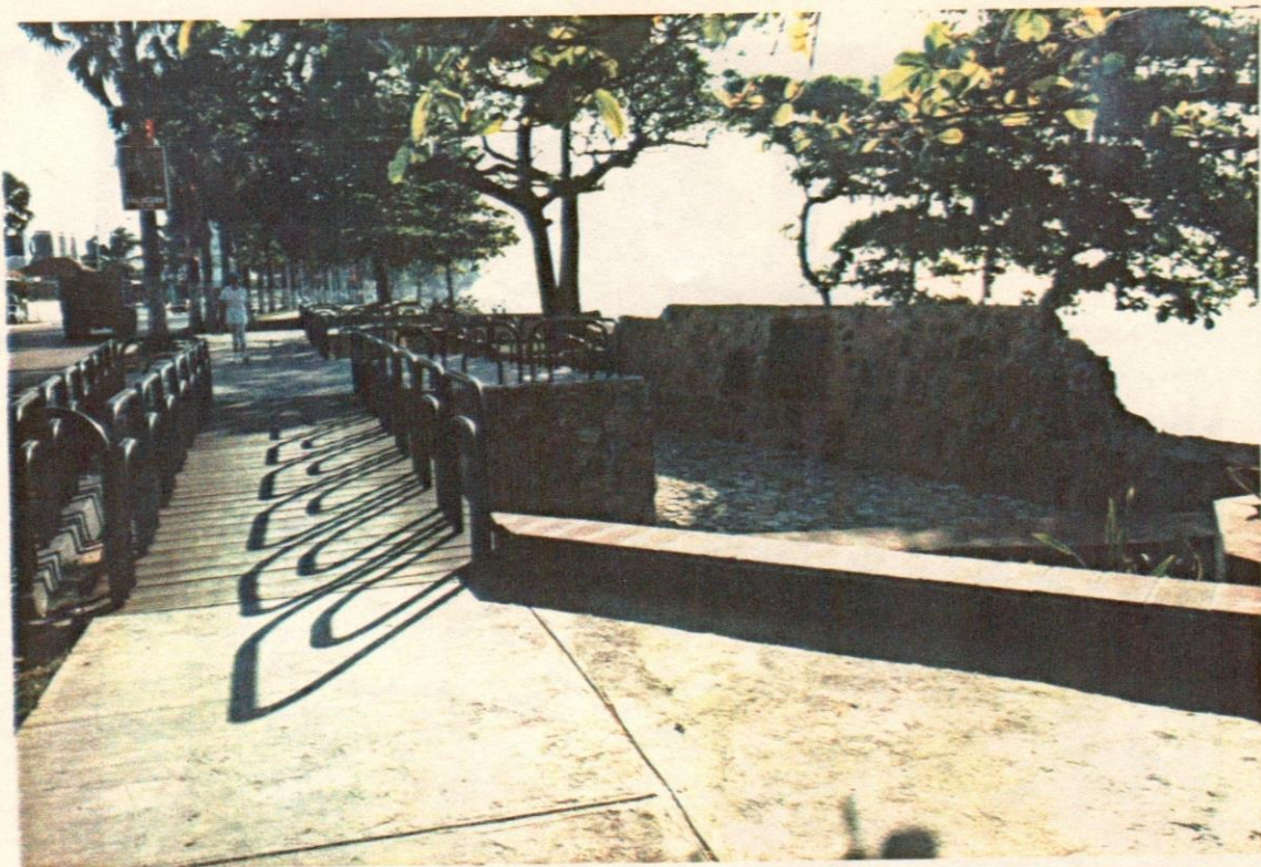
87-A Vista de los puentes.
