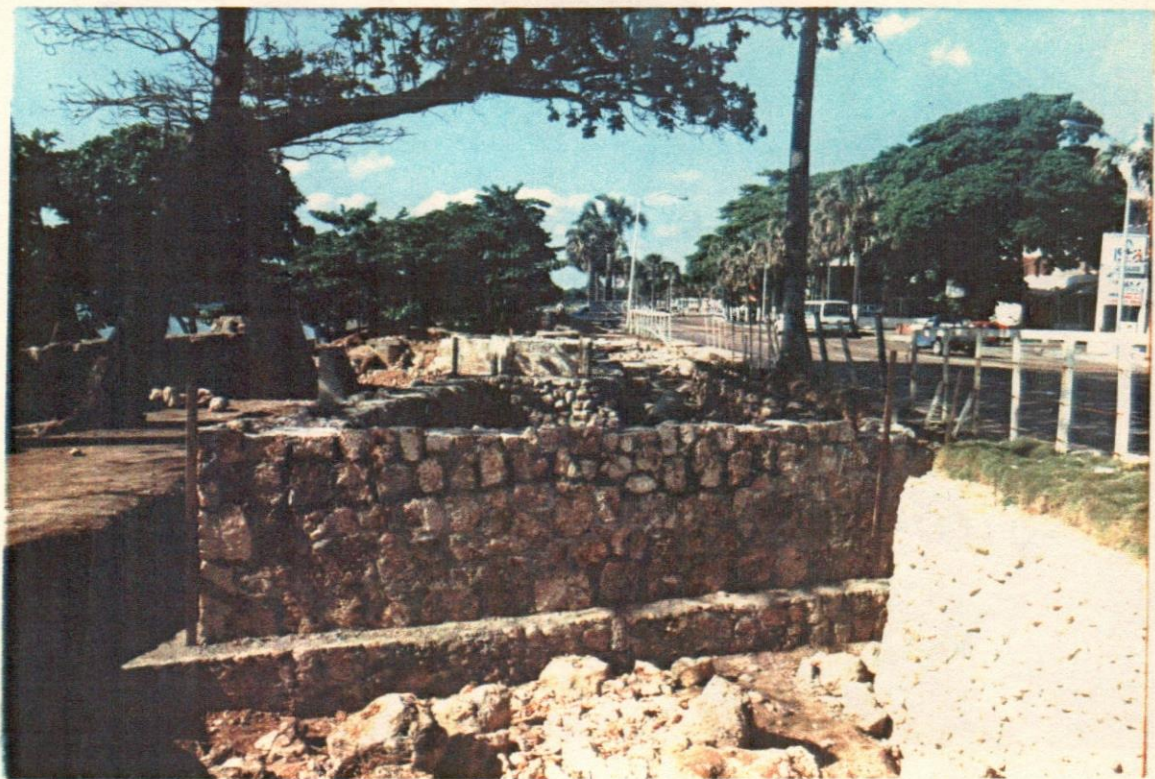
50- Fortín Sur-Este en reconstrucción.
