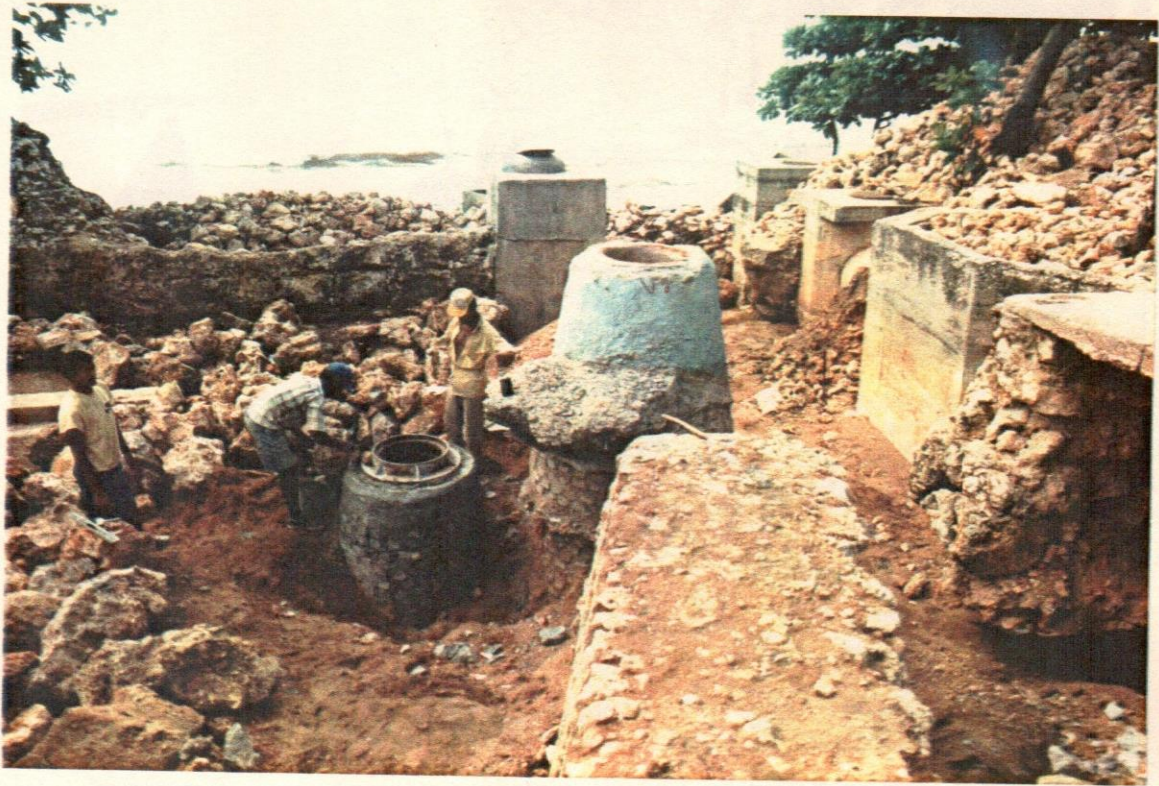
27- Registro sanitario, al centro, demolido y anulado por estar en la línea del muro.
