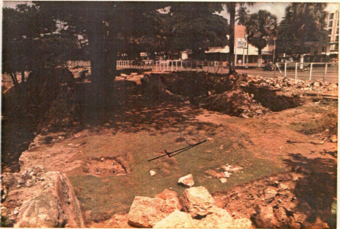
Foto 10-. Vista parcial del area después de iniciarse las excavaciones.
