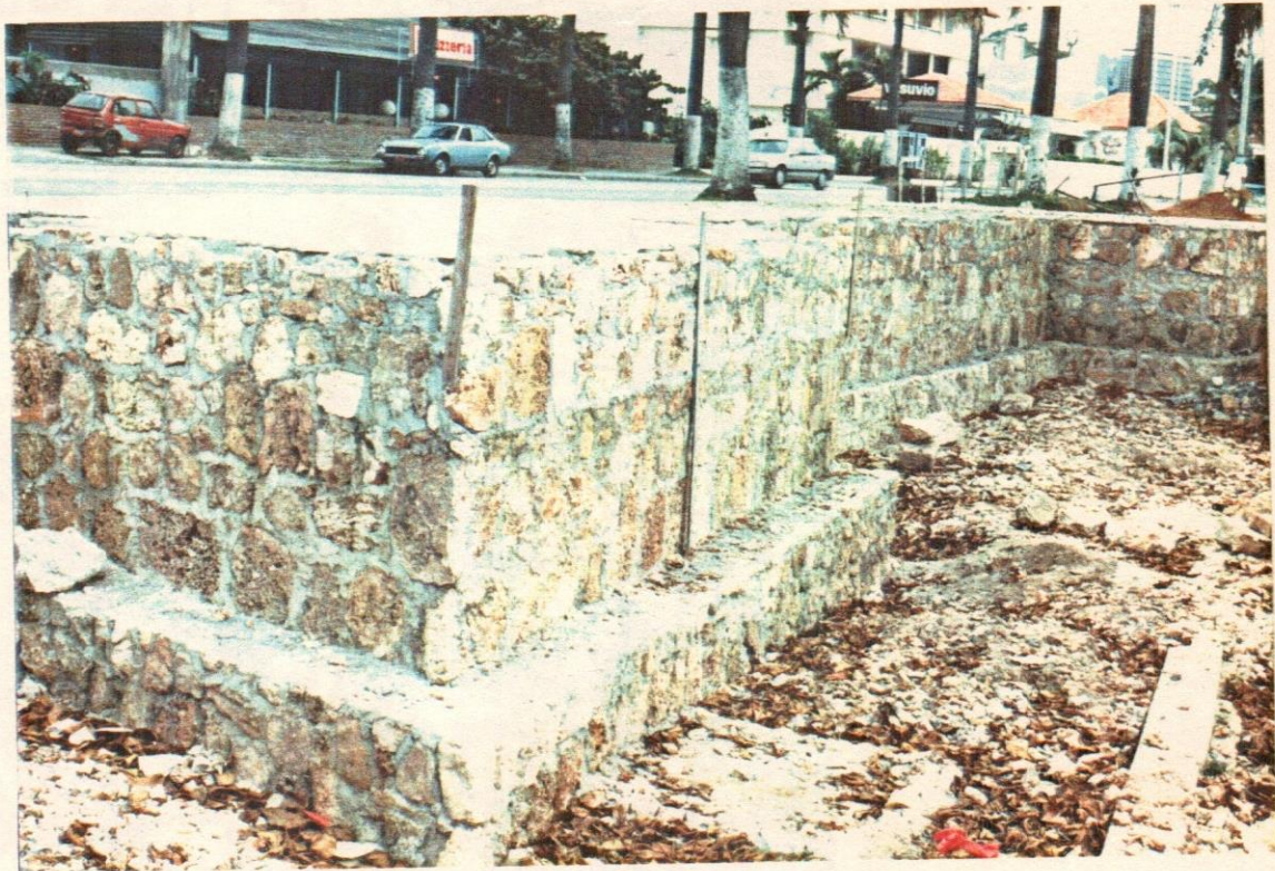
55- Fortín Sur-Oeste reconstruido.
