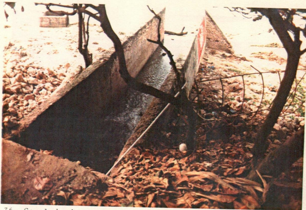
36- Canal de desague pluvial (y aguas negras) existente en el sitio.
