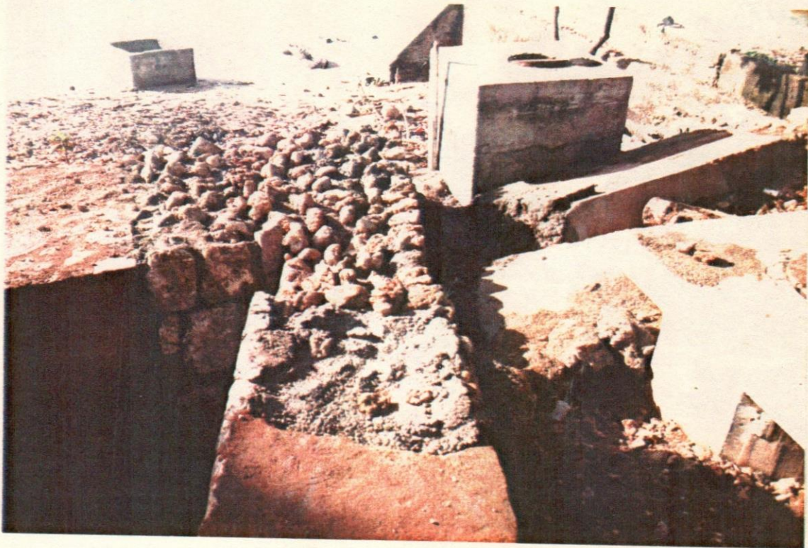
78- Muro oeste del foso, en reconstrucción
