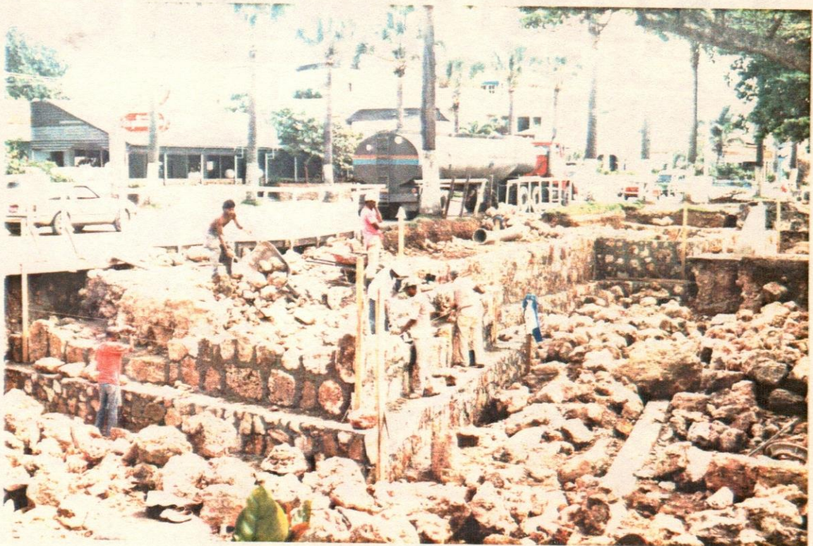
53- Proceso de reconstrucción del fortín Sur-Oeste.
