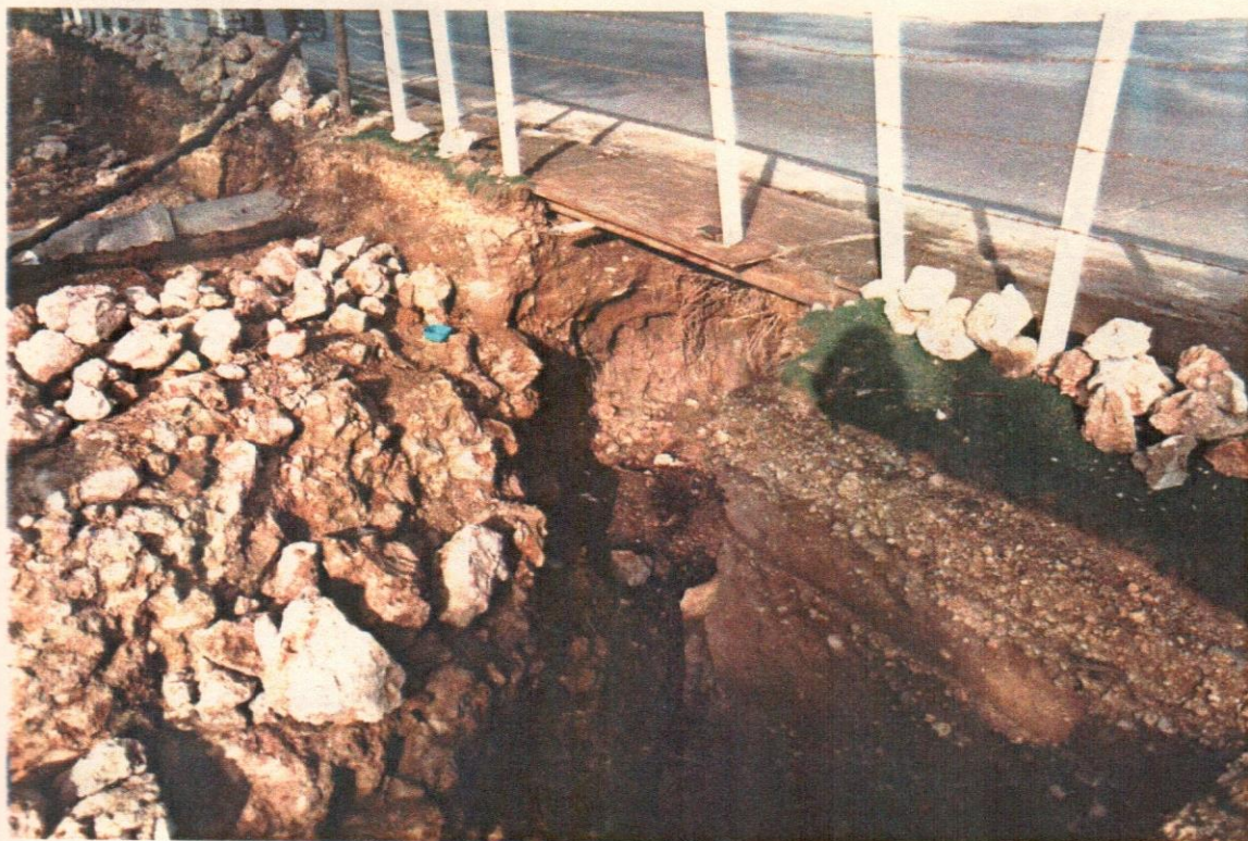
42- Excavación bajo la acera en el lado este.
