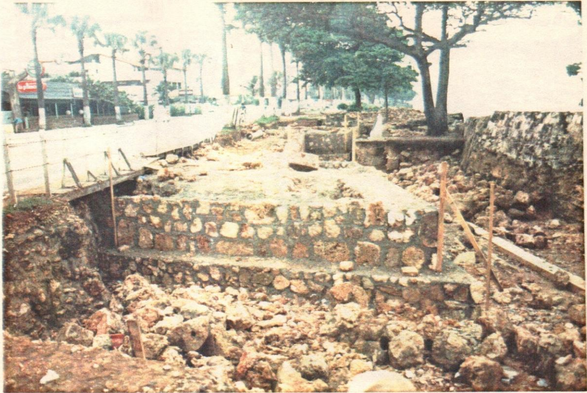
54- Fortín Sur-Oeste en reconstrucción.
