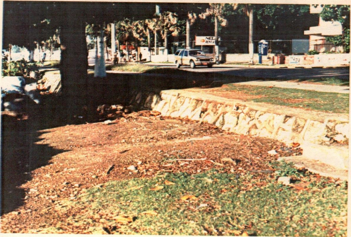
1- Vista parcial del Fuerte de San Gerónimo, al inicio de los trabajos.
