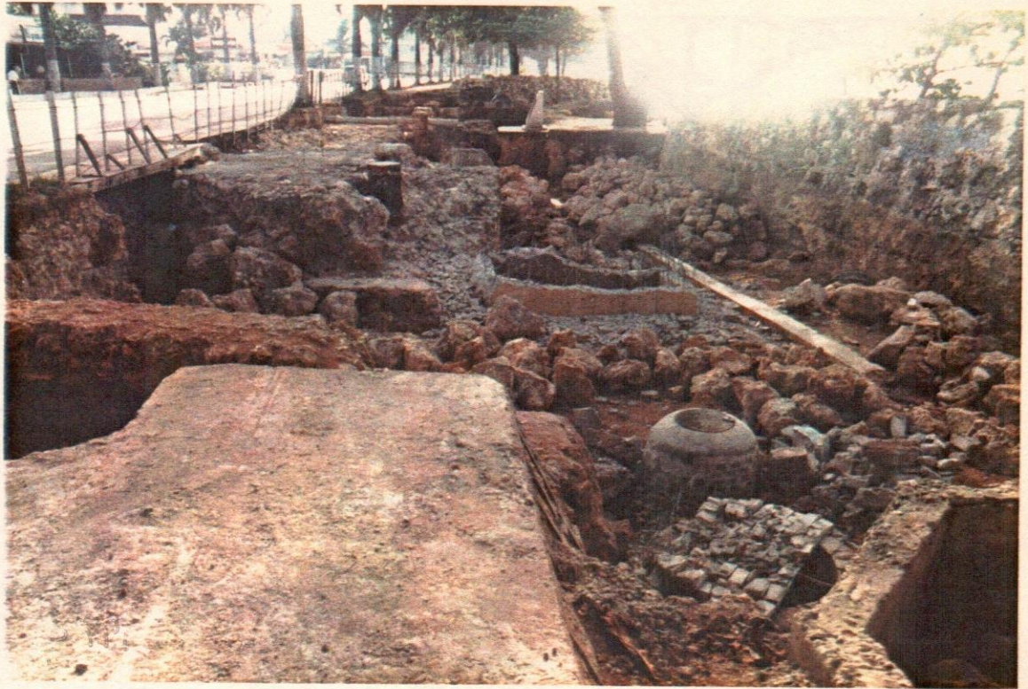
52- Restos del fortín Sur-Oeste, arriba a la izquierda. La mitad de este fuerte se encontraba donde se observa el registro en demolición.
