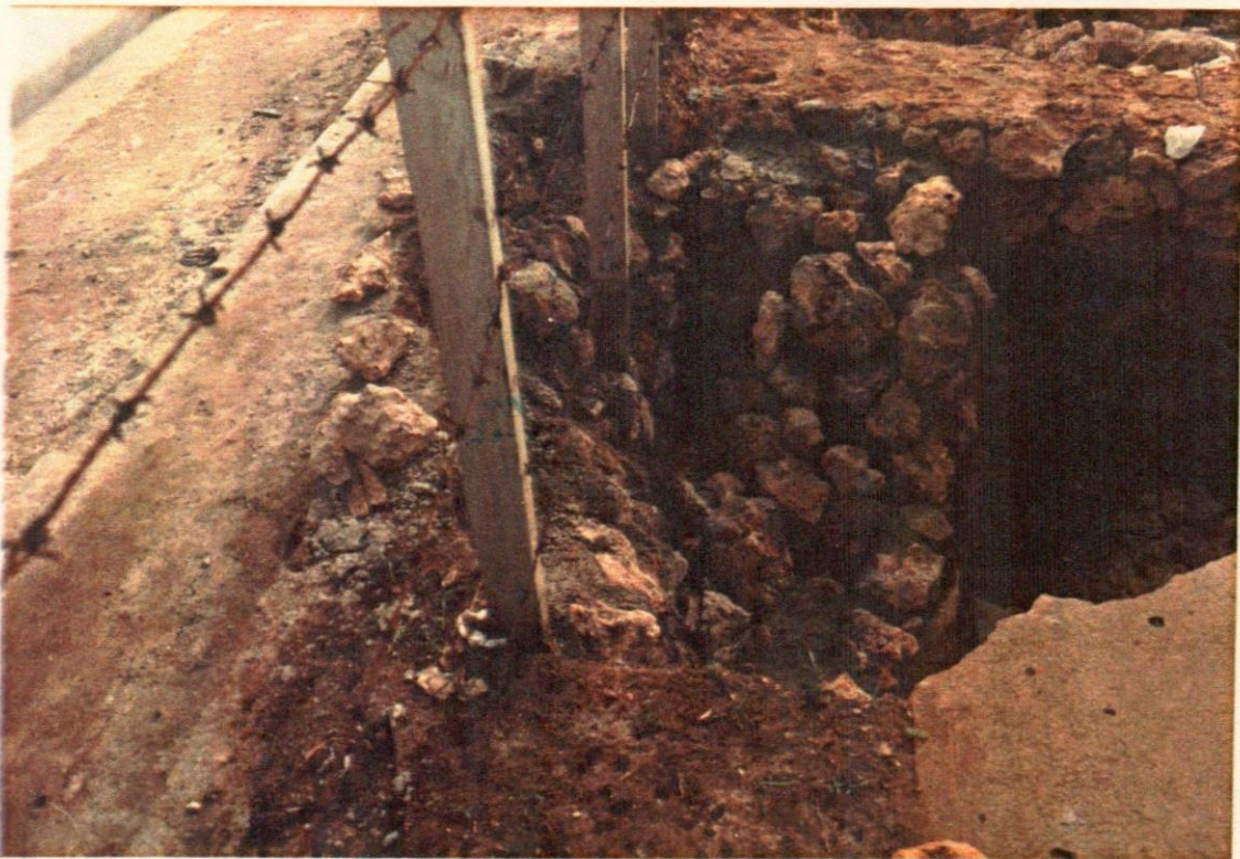
45- Relleno de hormigón y piedras rústicas en el derrumbe visto en la foto No.41.
