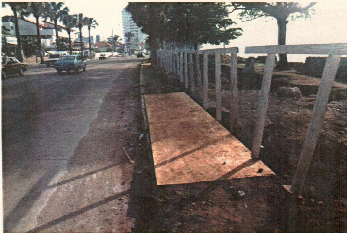
22- Vista de puentes en madera sobre las excavaciones.
