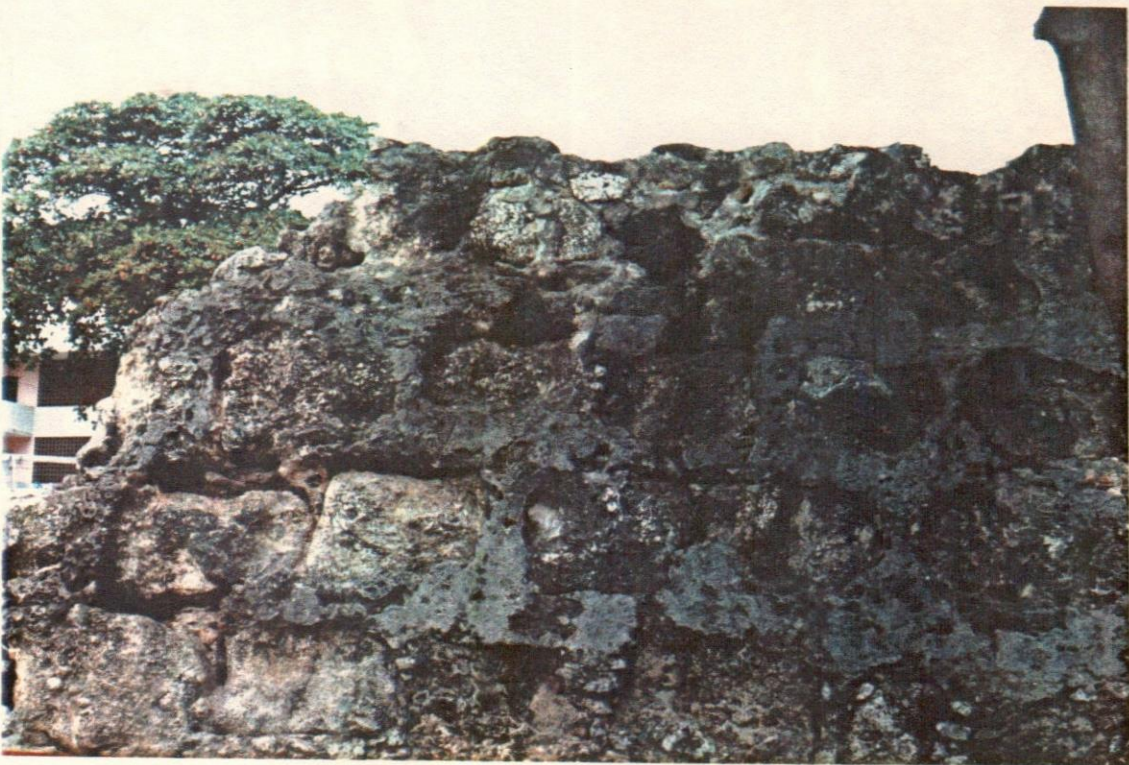
61- Vista del muro exterior del foso.
