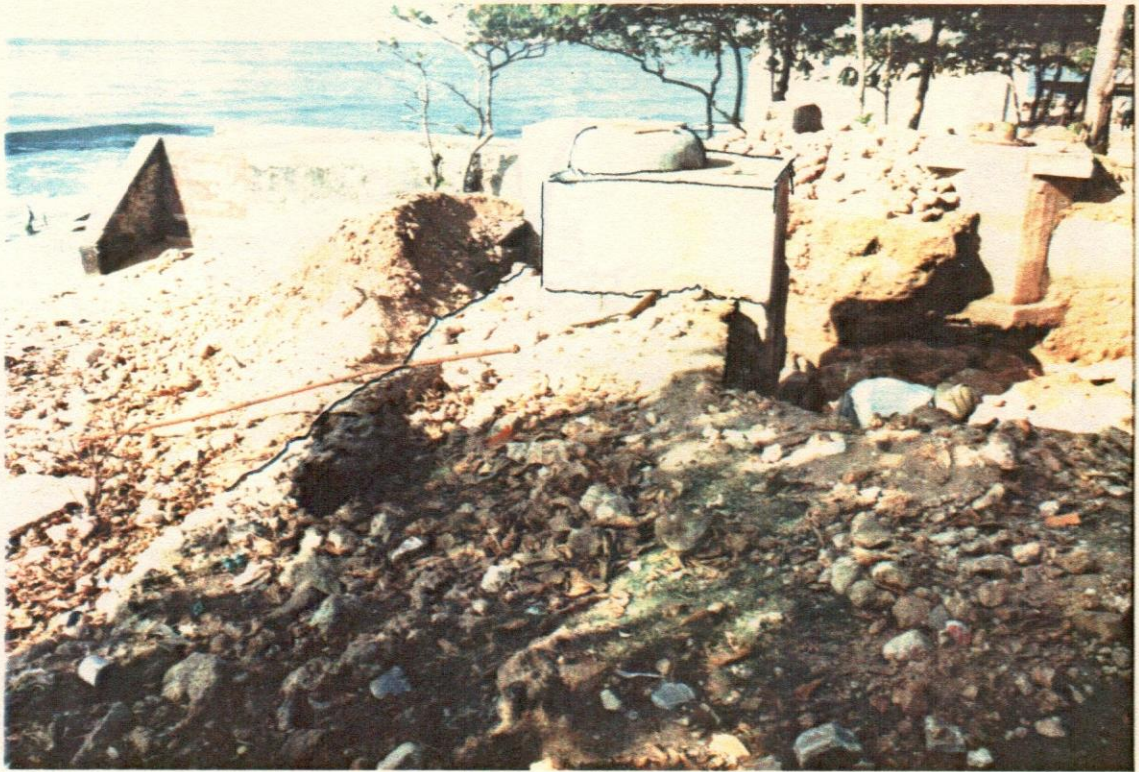
29- Registro sanitario que estaba construido sobre el muro del foso. Fue demolido y reconstruido. Fotos No.23 y 29.
