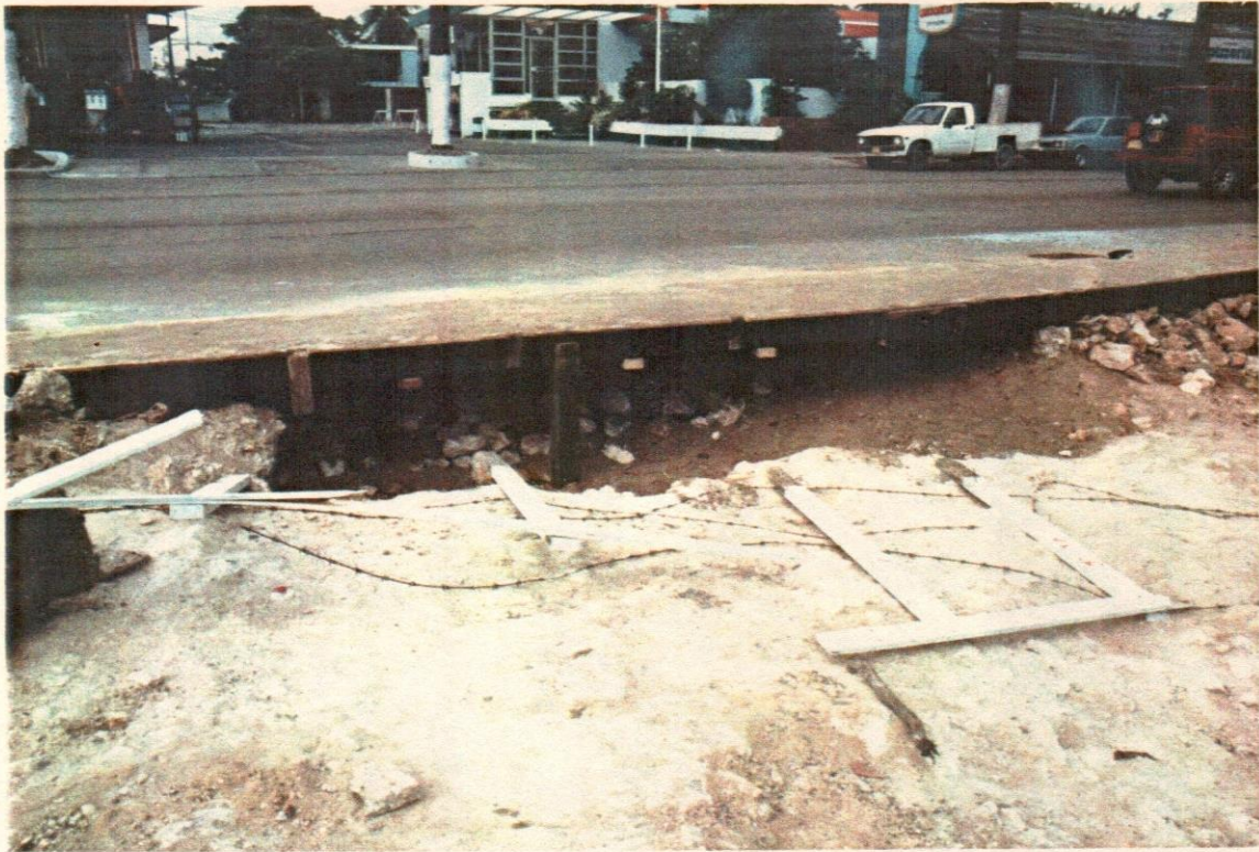
21- Puente en madera para crear un paso peatonal.
