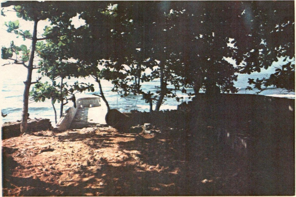
90- Vista de la plaza oeste, en construcción. Ya están construidos los muros de contención, el mirador y el relleno del area.
