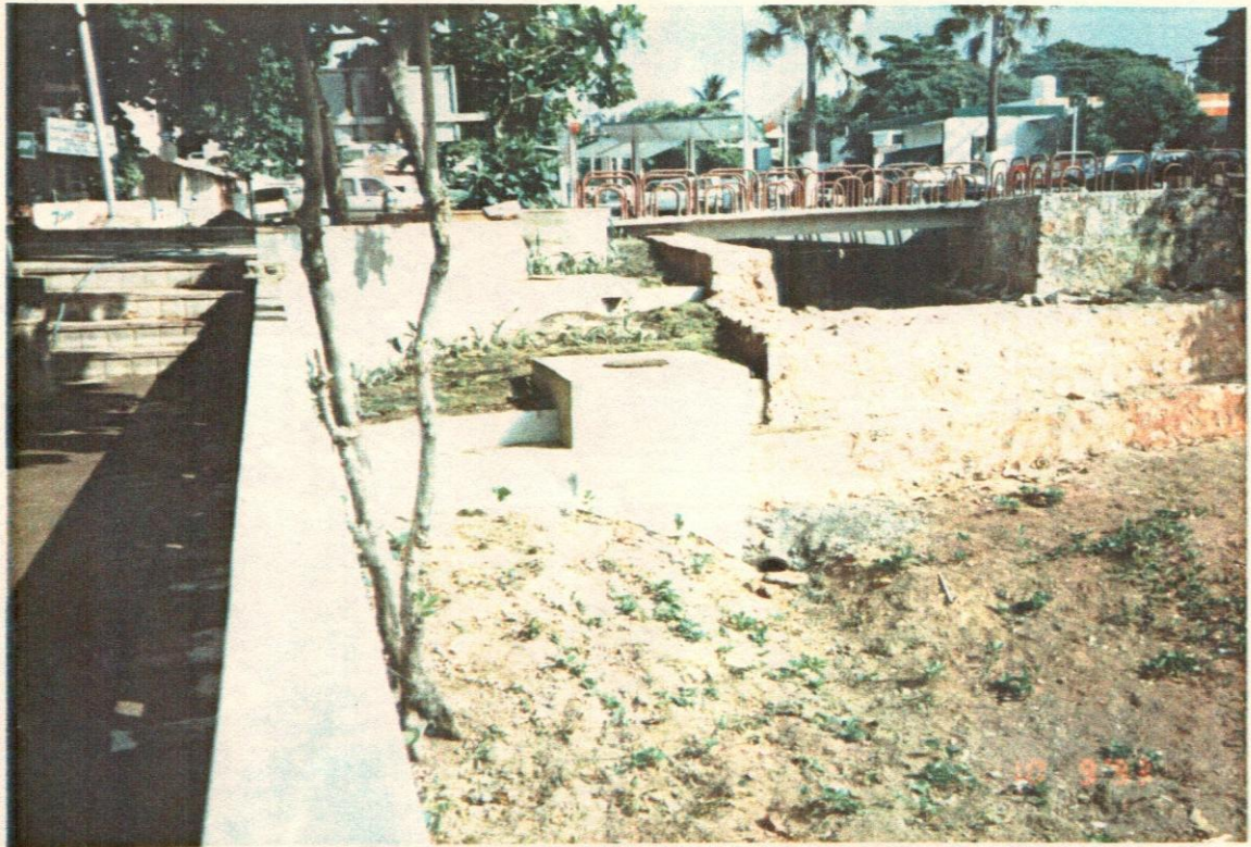
94- Vista parcial de la Plaza Oeste, llamada Plaza de los Pescadores. Se observa ya el piso en losetas de hormigón.
