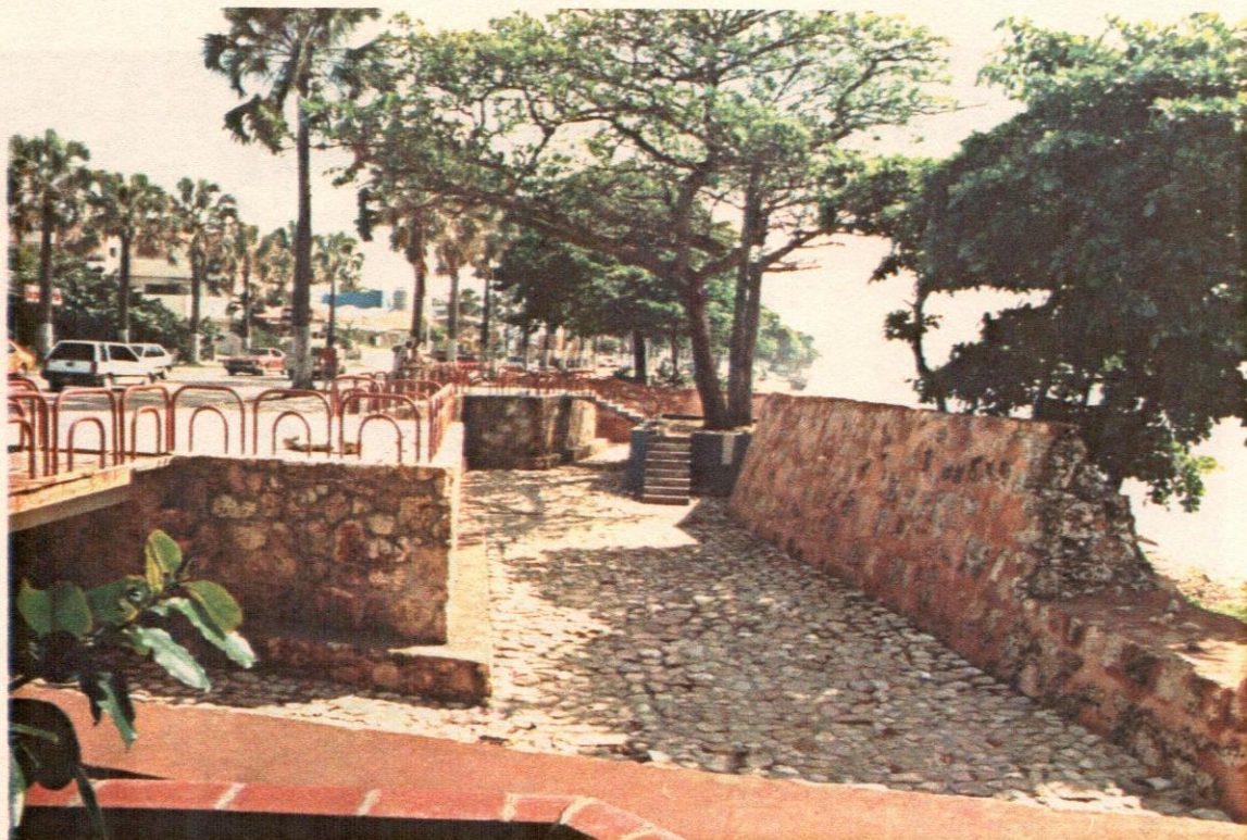
124- Piso del foso terminado.
