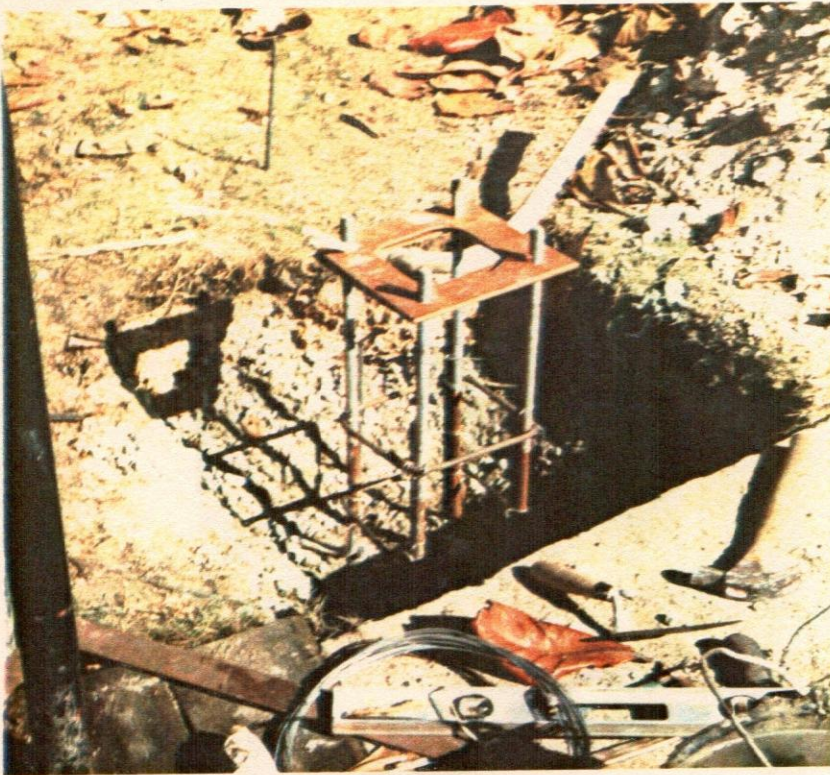
114-A-B y C- Bases de hormigón armado para los postes del alumbrado eléctrico.
