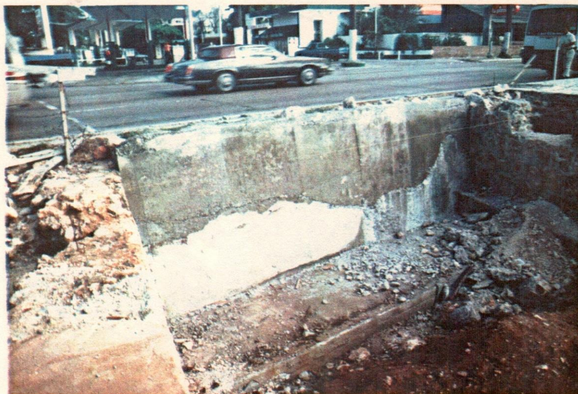
87- Muro de contención.
