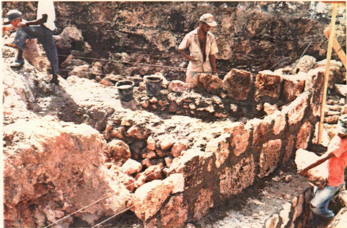
49- Proceso de reconstrucción del fortin Sur-Este. Toda la esquina en construcción fue destruida por la explosión y por el soterrado de los tubos del alcantarillado.
