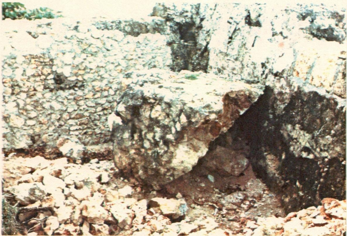
127- y 127-A Pedazo de la punta del fortín sur-este, caída durante la explosión del 1937 y dejado expuesto en el sitio.
