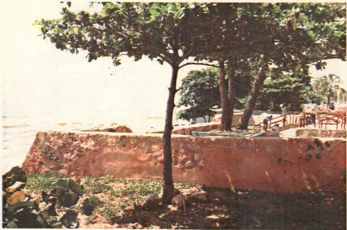
73- Muro este ya restaurado.
