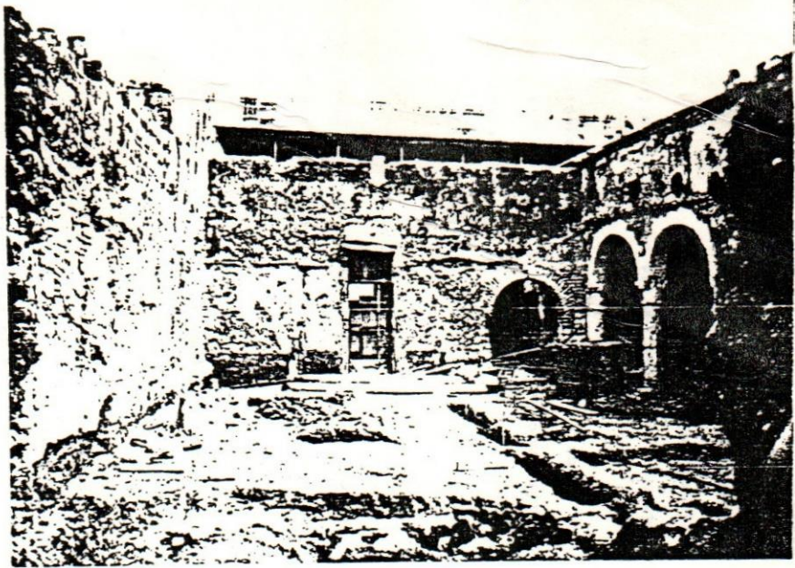
11. VISTA GENERAL. ETAPA FINAL .
