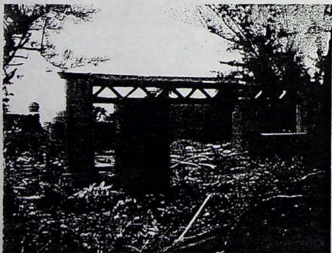
Image07 CASA AUTON DESTRUIDA C.N. PENSON
