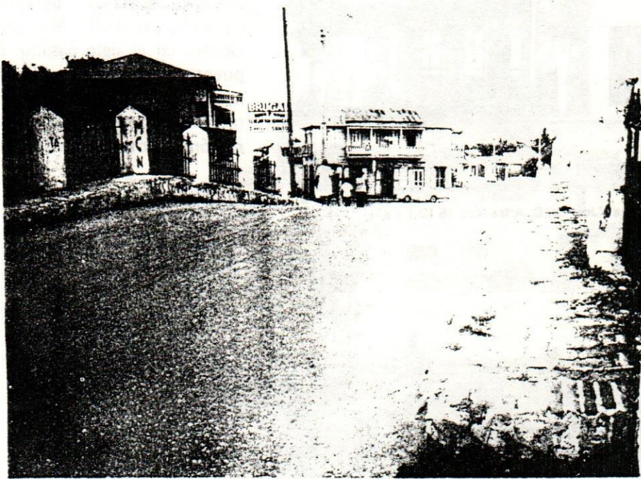
Puente de la Guinea
