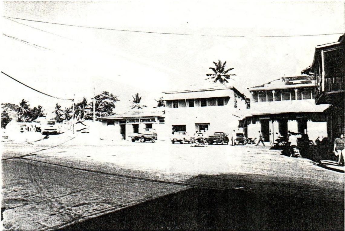
Plazoleta frente al Puente de la Guinea
