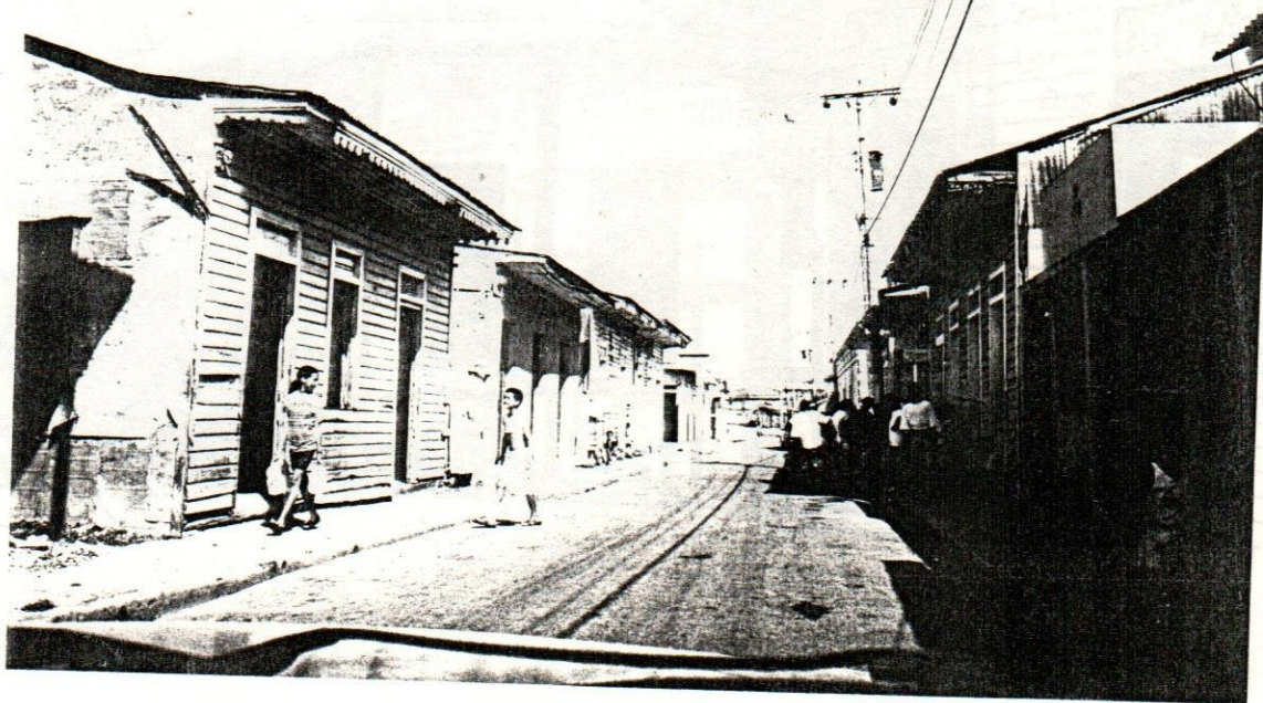
Restauración. Al fondo 1a Ave. Colón. Antes, esquina 30 de Marzo.
