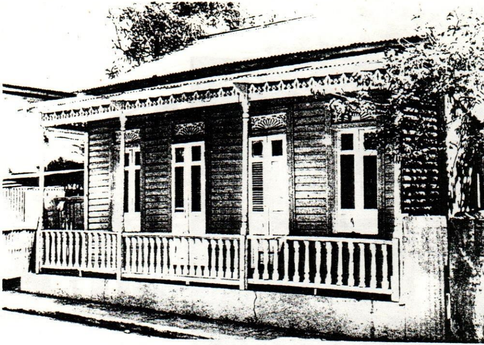
Baranda en mal estado y con faltantes
