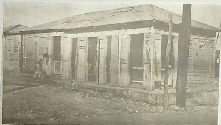
Año 1940: Centro Comercial del señor Sócrates Lagares contiguo al Mercado Público antiguo. Album Foto de Barahona. Pedro A. Vargas C. (1956).
