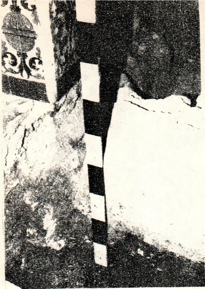
Zapata y muro de contención.
