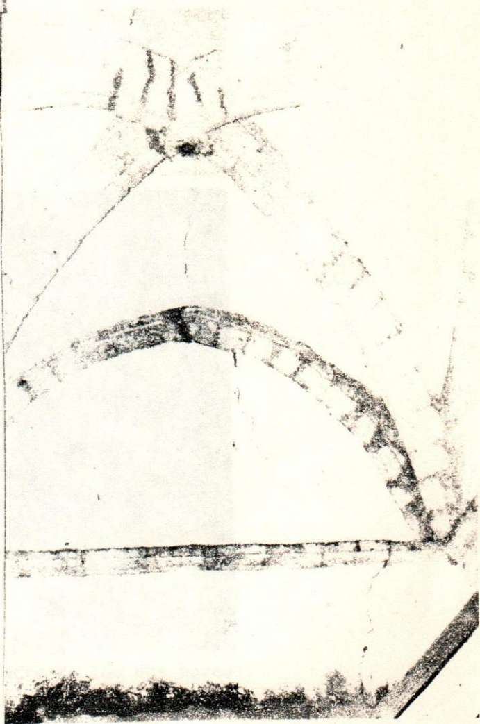
Agrietamiento del techo en sus arcos de crucería.
